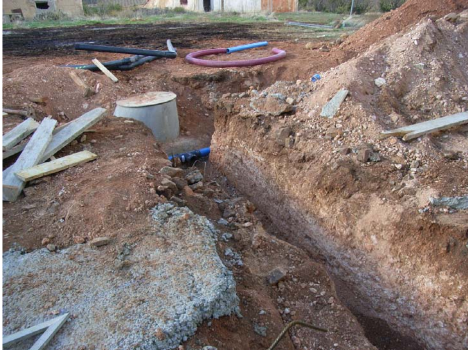
PK 0+ 000 Salida del depósito.
