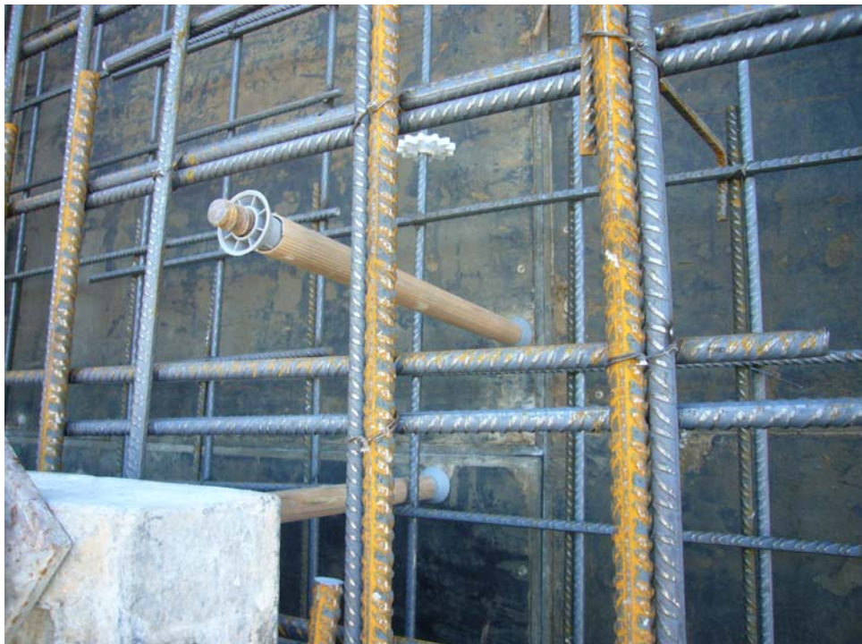
Separadores. De los encofrados del muro y de armaduras de los encofrados.
