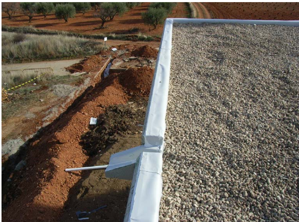
Obras de interconexión entre depósitos vistas desde la cubierta.
