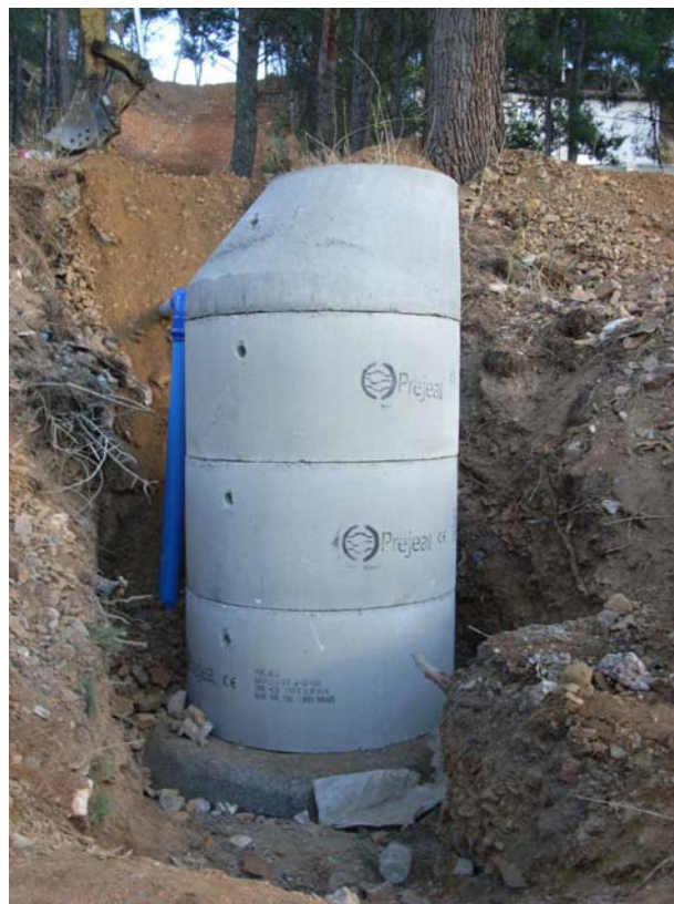
PK 0+200. Pozo de resalto, justo al otro lado de la carretera.
