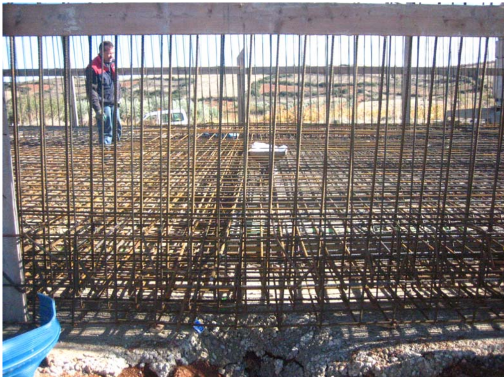
Colocación de la toma de desagüe.
