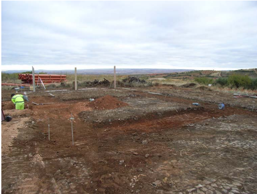
Excavación de zanjas drenantes y presolera.
