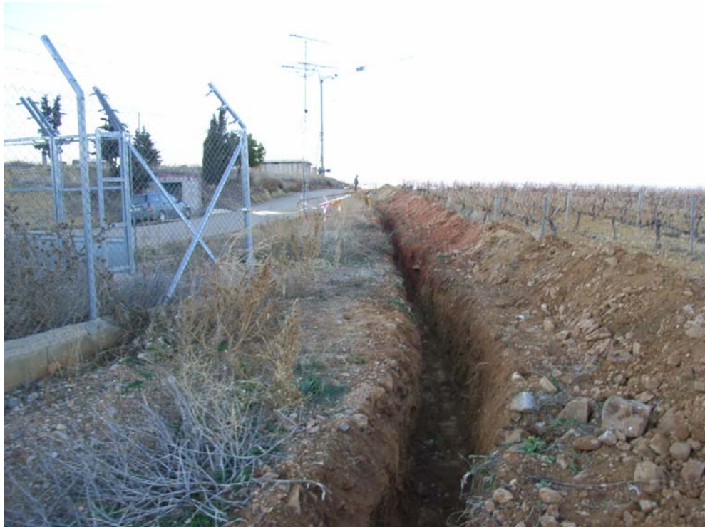
Zanja entre depósitos.
