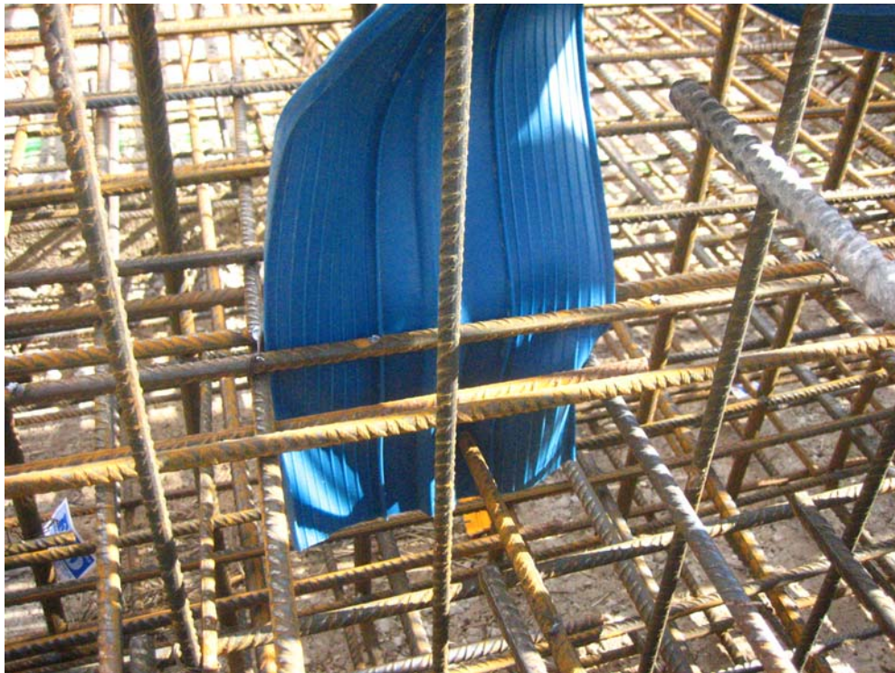
Anclaje de junta Gump vertical para que quede embebida en la solera.
