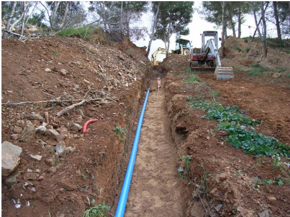
PK 0+160. Tendido de la tubería de distribución entre la masa forestal.
