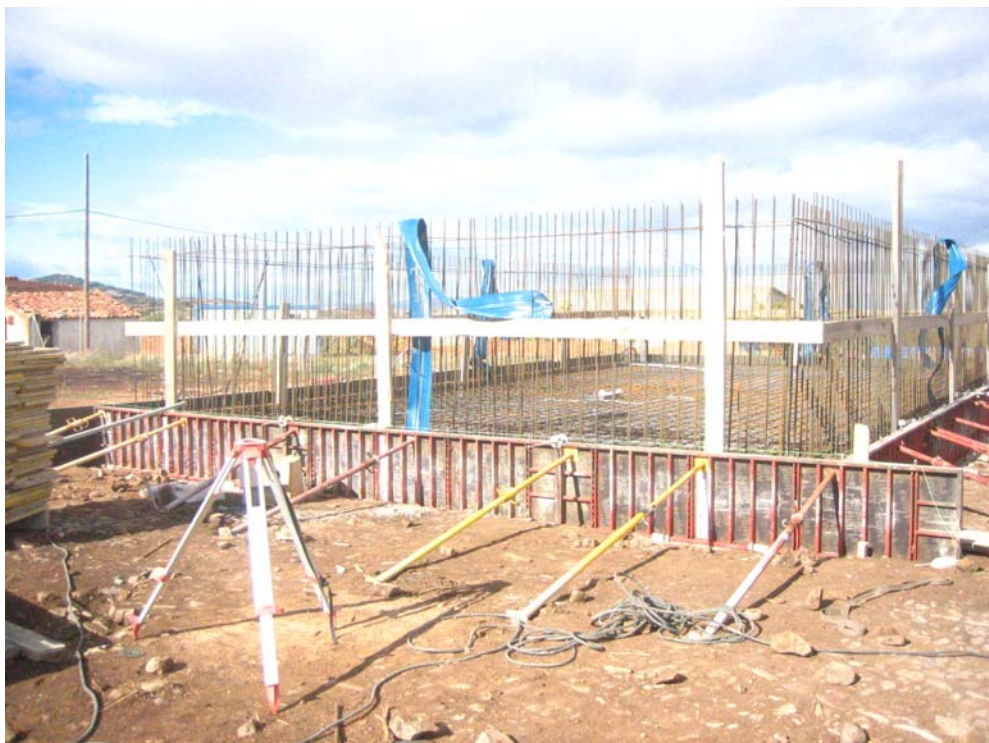
Encofrado dispuesto a la espera de hormigonar.
