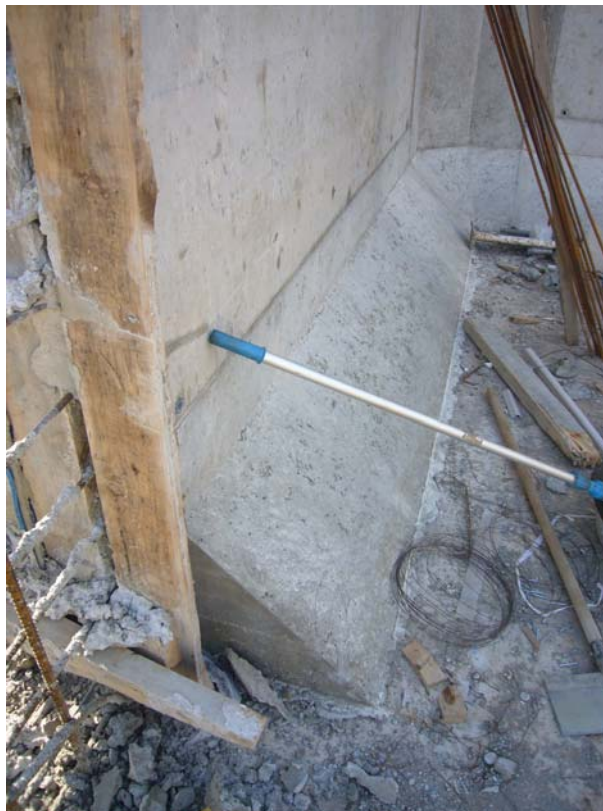
El mismo detalle una vez fraguado el hormigón y desencofrado.
