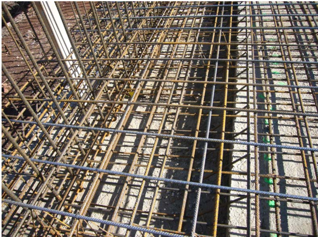
Armaduras de los nervios de la solera.
