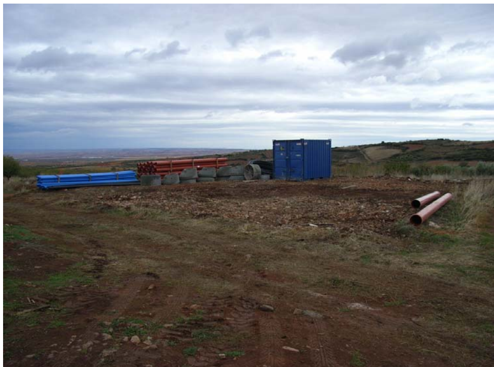
Zona de acopios. Caseta de obra, tuberías y piezas prefabricadas.
