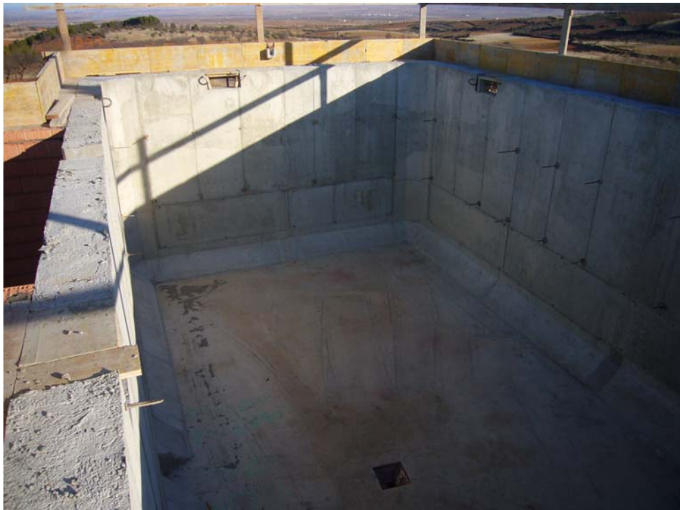
Regularización del asiento de las placas y vista general del vaso.
