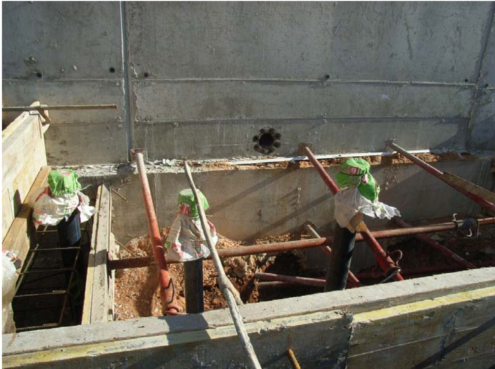
Esperas de los tubos de conexión entre en encofrado del zócalo.
