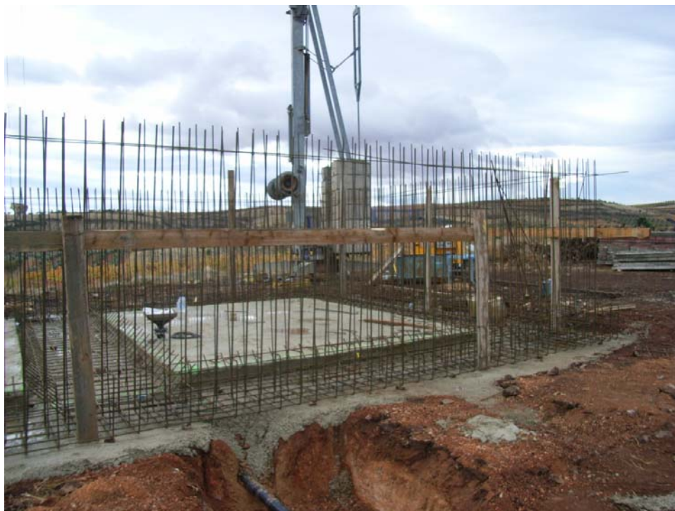
Hormigón de limpieza y presentación de las primeras armaduras.
