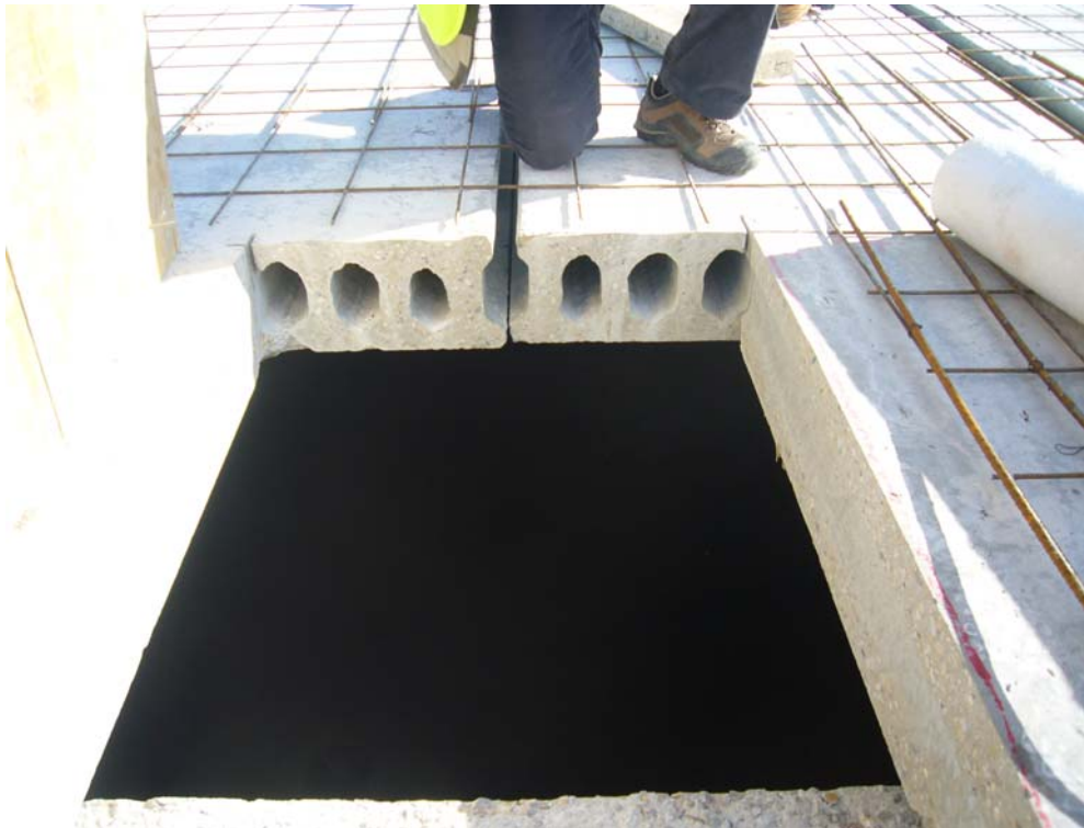
Detalle, en el acceso al vaso, del canto de la placa alveolar.
