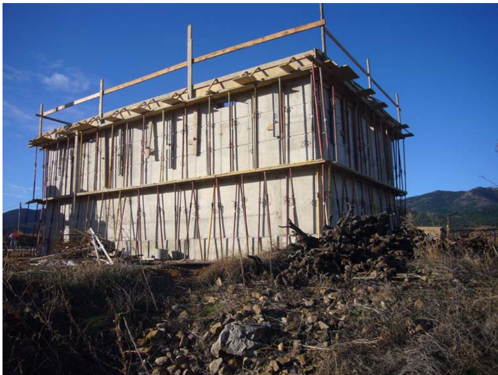
Encofrado para ejecución de alero, antes de recibir las placas alveolares.
