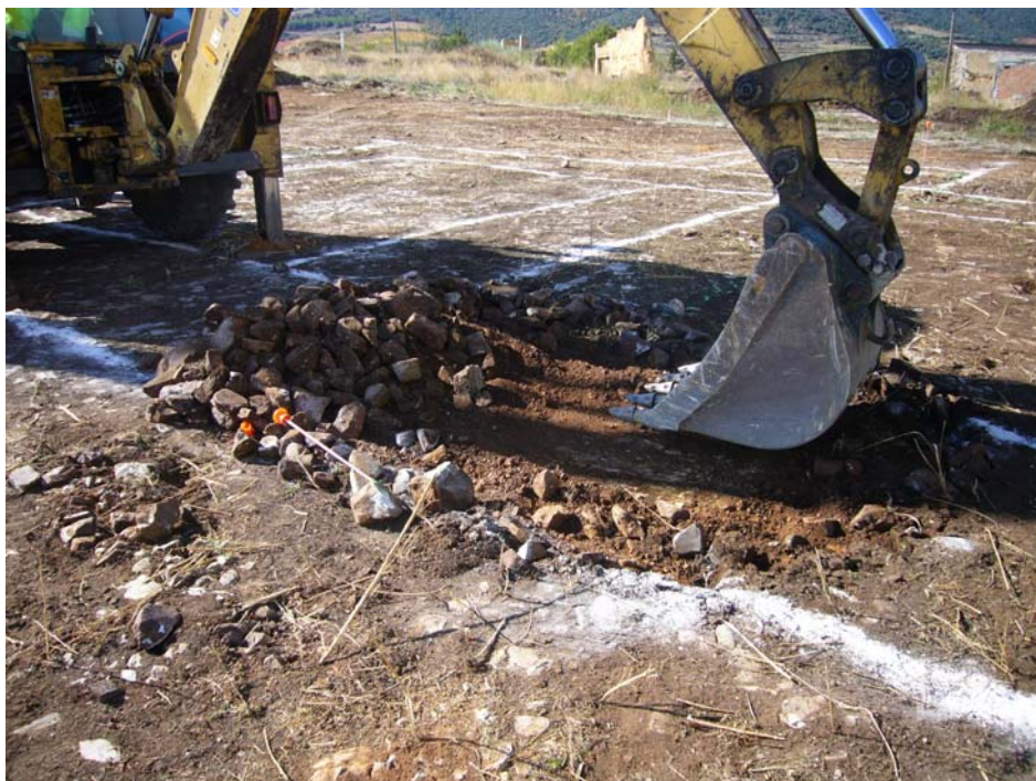
Inicio de la excavación. La zanja de drenaje servirá de calicata.
