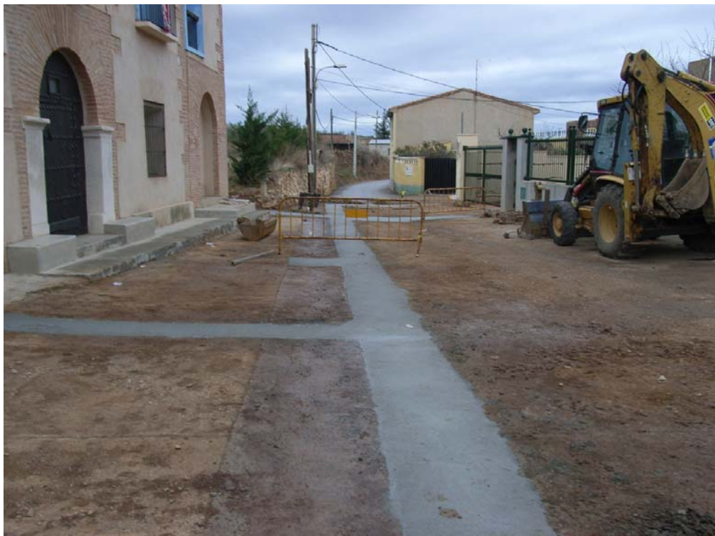
PK 0+435. Calle Pilar Bayona. Reposición de pavimento existente.
