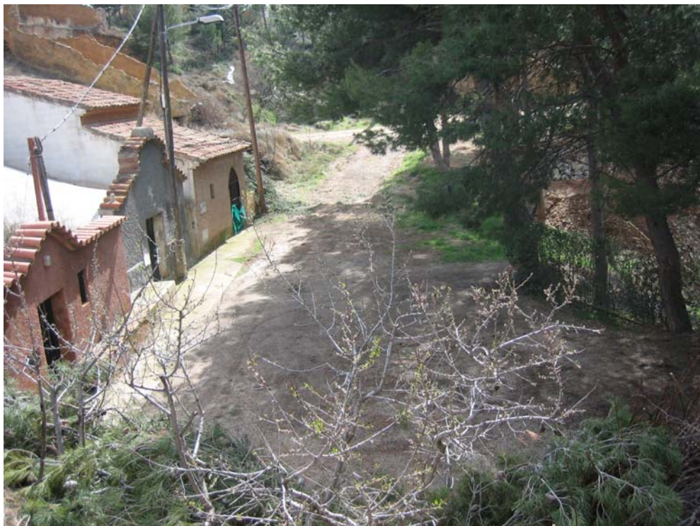
PK 0+130. Viviendas a conectar con las dos redes, distribución y desagüe.
