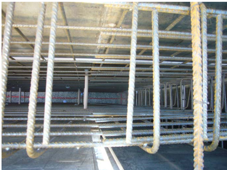
Disposición de armaduras del alzado. Al fondo junta hidroxpansiva colocada.
