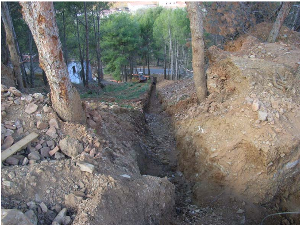
PK 0+150. Zanajeado evitando talas innecesarias del arbolado.
