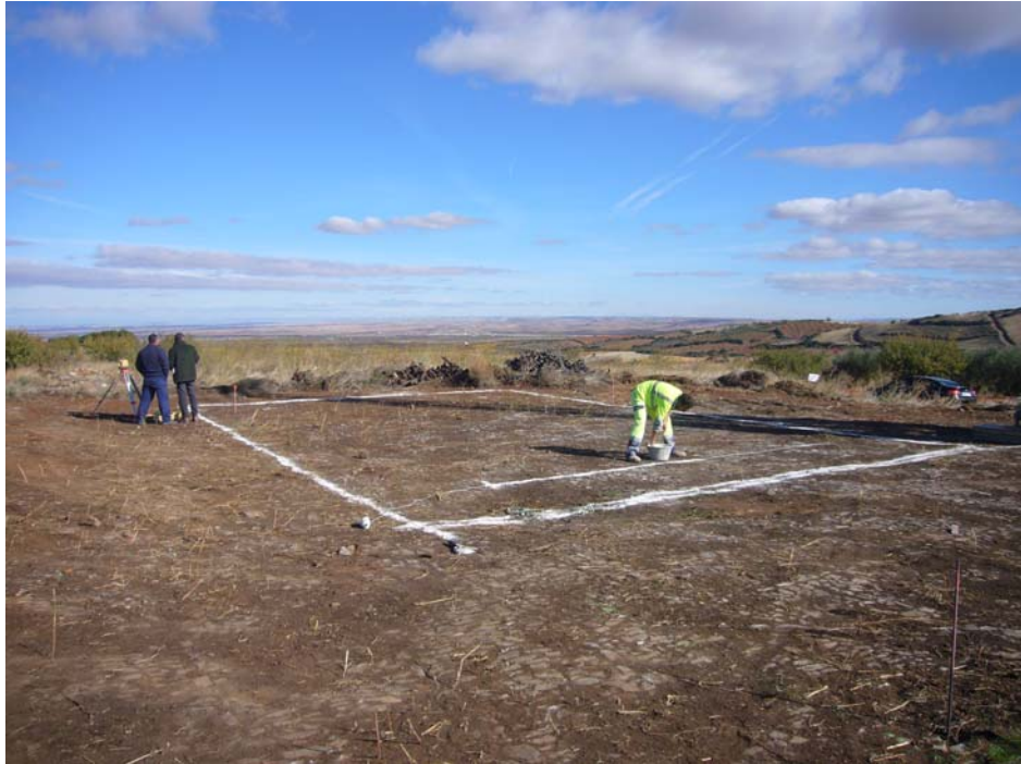
Replanteo con yeso sobre la superficie limpia.
