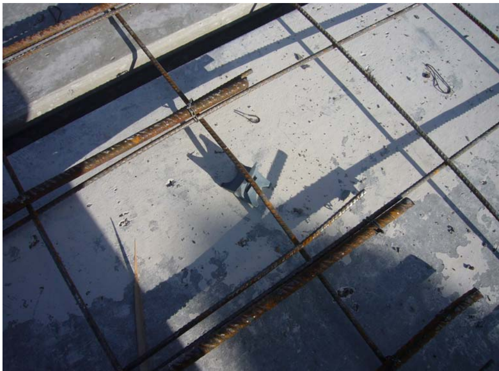
Detalle de otro tipo de separador de las armaduras.
