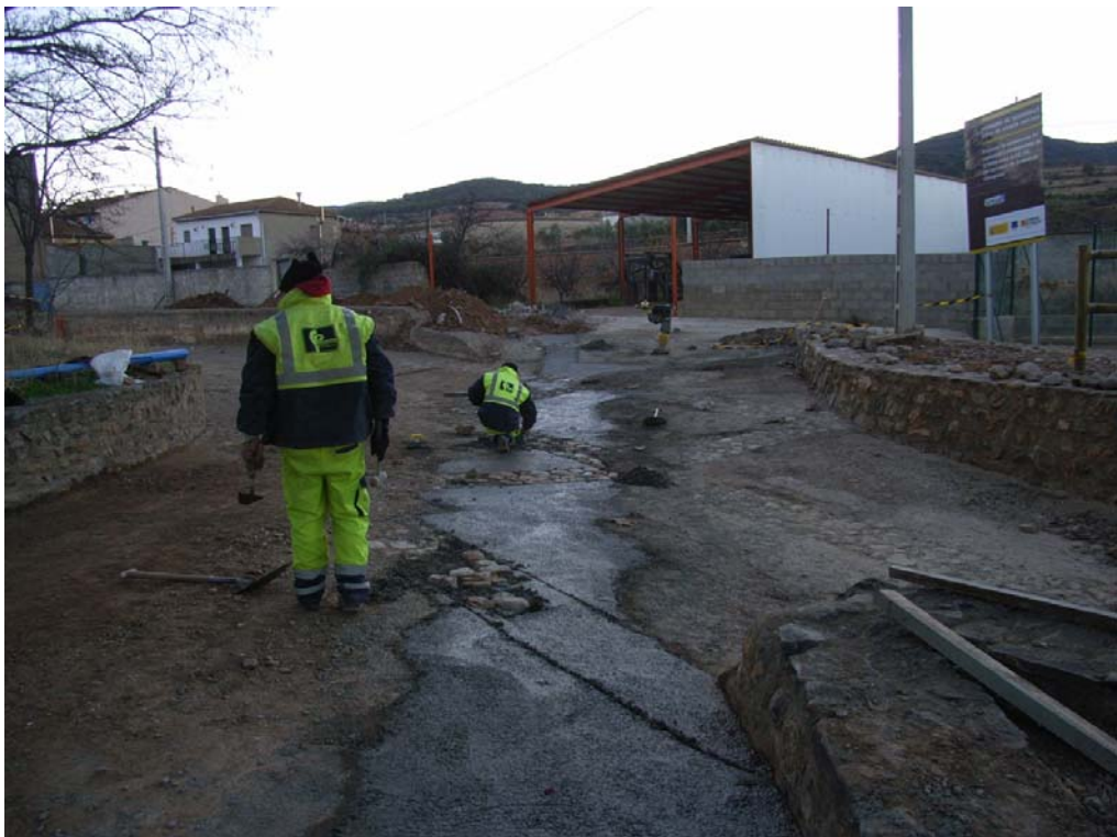
PK 0+300. Ejecución del cruce del barranco.
