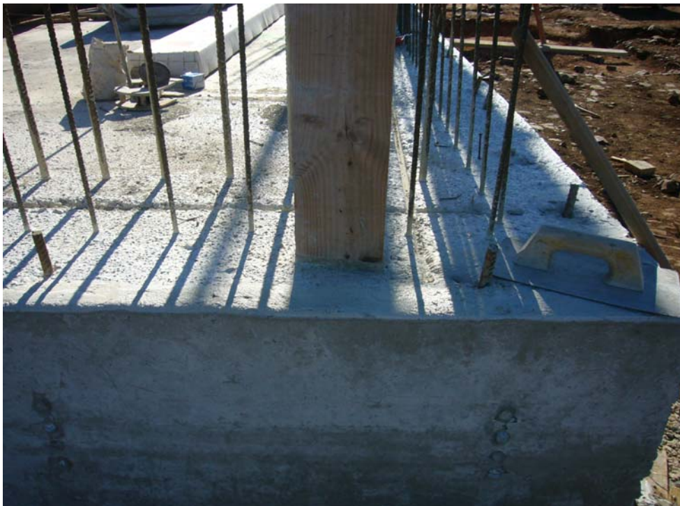
Detalle de ejecución. Esperas, puntales para facilitar el encofrado, rebaje para junta hidroexpansiva, etc.
