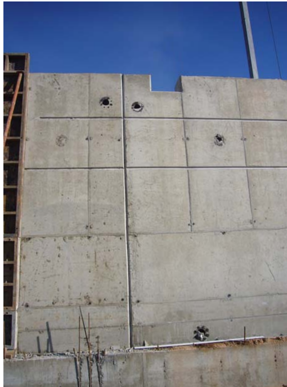
Zona que dará a la caseta de llaves. Pasamuros y esperas del zócalo.
