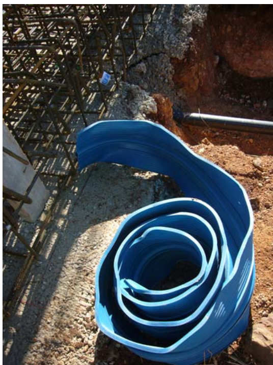
Junta de estanqueidad tipo Gump.
