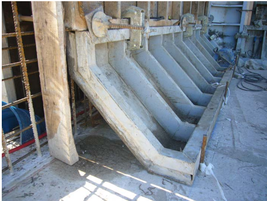
Detalle del encofrado de los muros en su encuentro con la solera.
