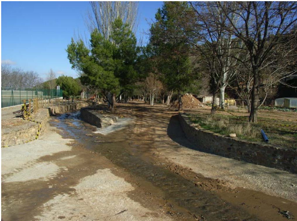
PK 0+350. Cruce del barranco.
