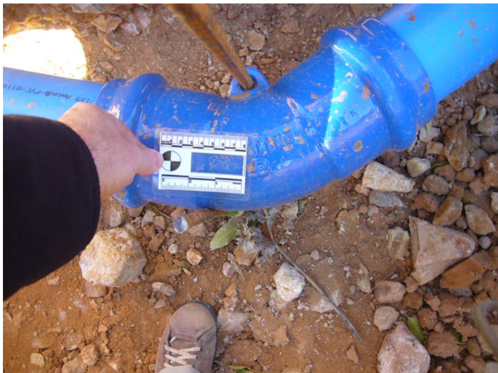
Codo a 45° de fundición dúctil tipo natural.
