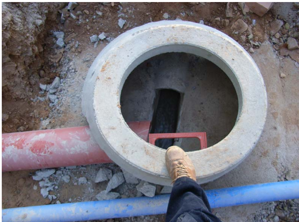
PK 0+250. Conexión del desagüe del deposito al saneamiento.
