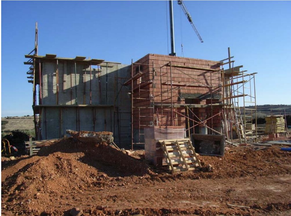
Finalización de las paredes de termoarcilla de la caseta de llaves.
