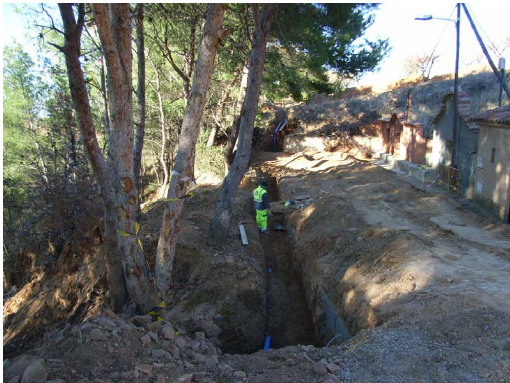
PK 0+150. Las tuberías ya están instaladas y tapadas con arena.
