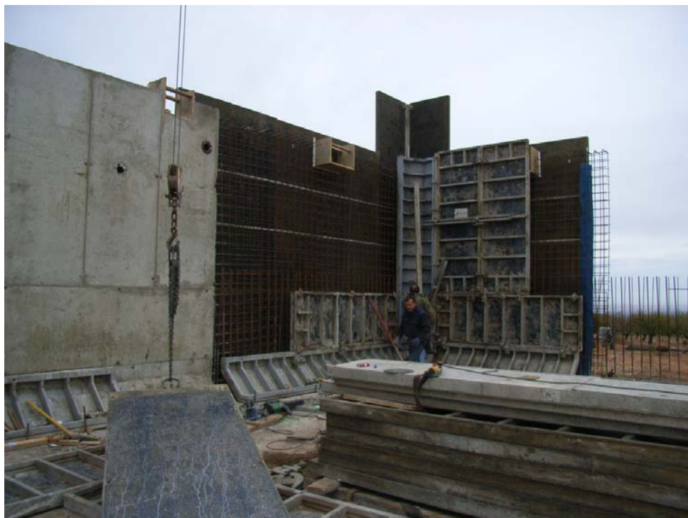
Segundo proceso de encofrado.
