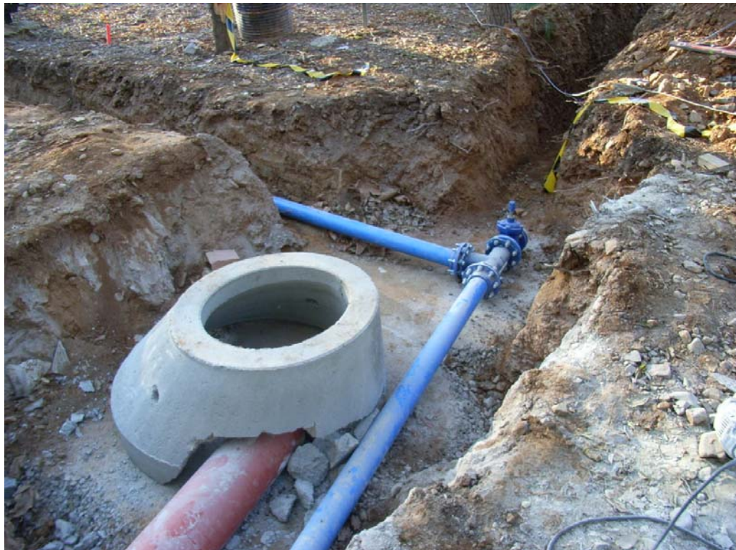
PK 0+250. Quiebro de la distribución y derivación a una fuente.
