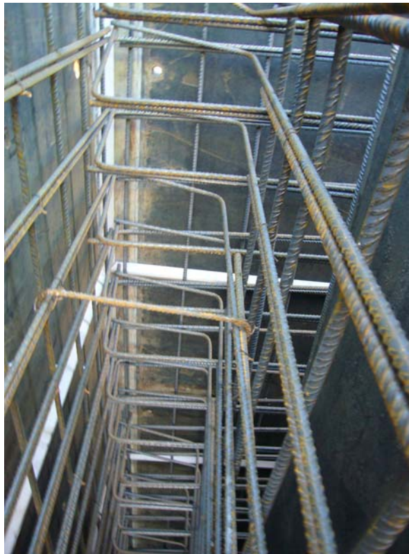
Disposición de armaduras en la zona del encuentro entre muros.
