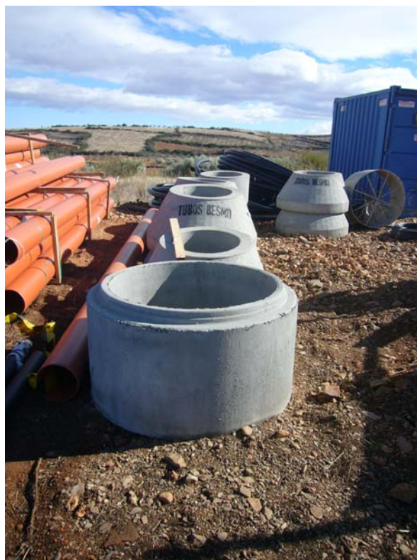
Piezas prefabricadas para la formación de pozos: anillos y brocales.
