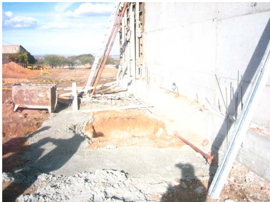
Hormigón de limpieza para el zócalo de la caseta de llaves.
