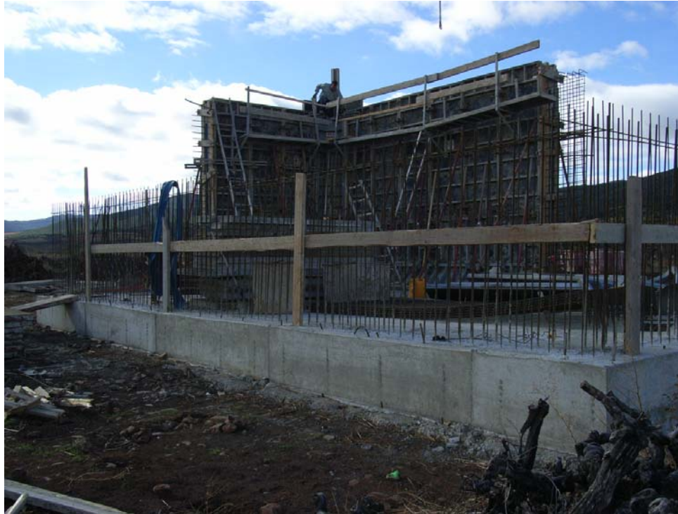
Encofrado del primero de los cuatro alzados en los que se dividieron los muros.
