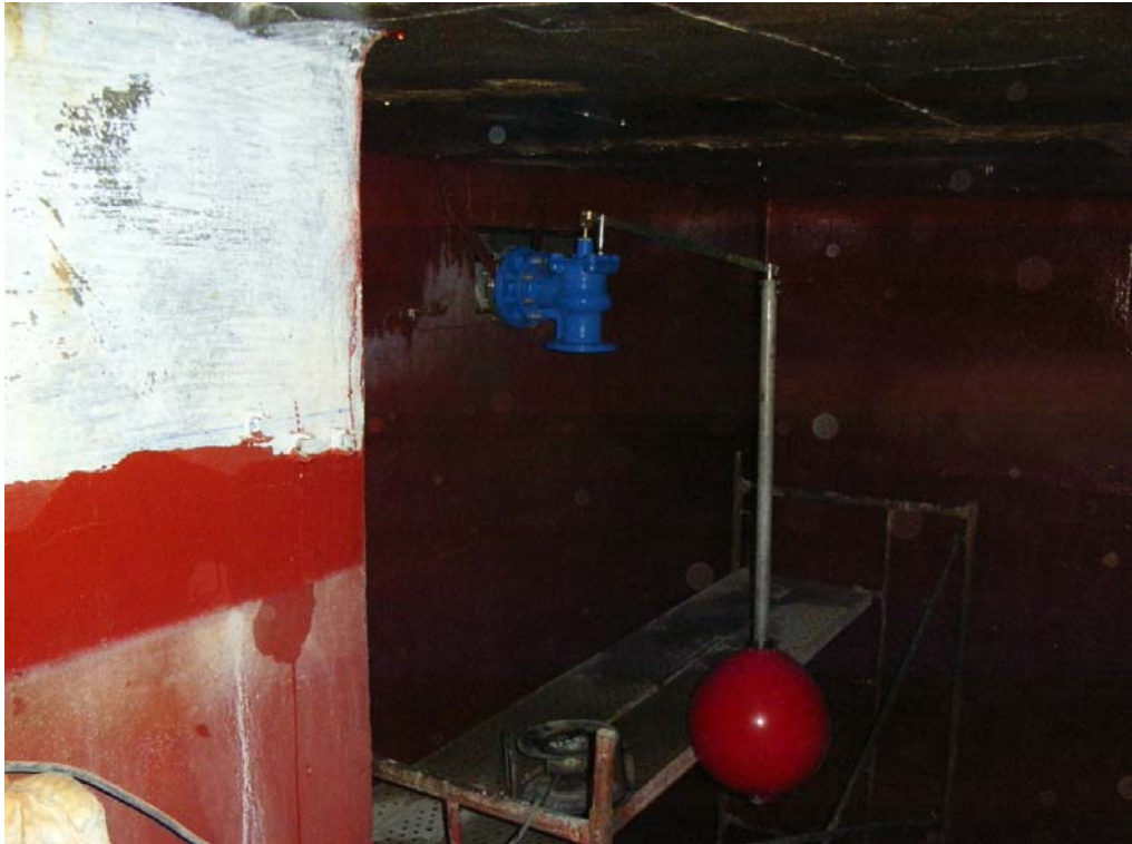
Enfoscado del techo, nueva pintura y válvula flotador en deposito viejo.
