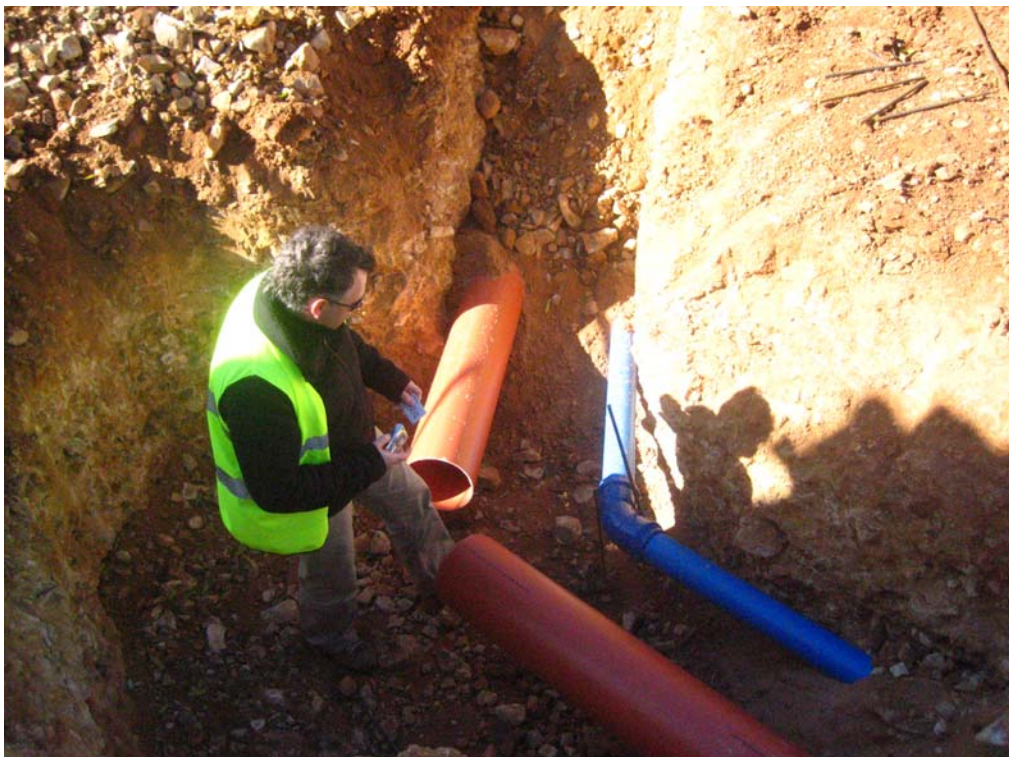
PK 0+090. Situación de un pozo de registro.
