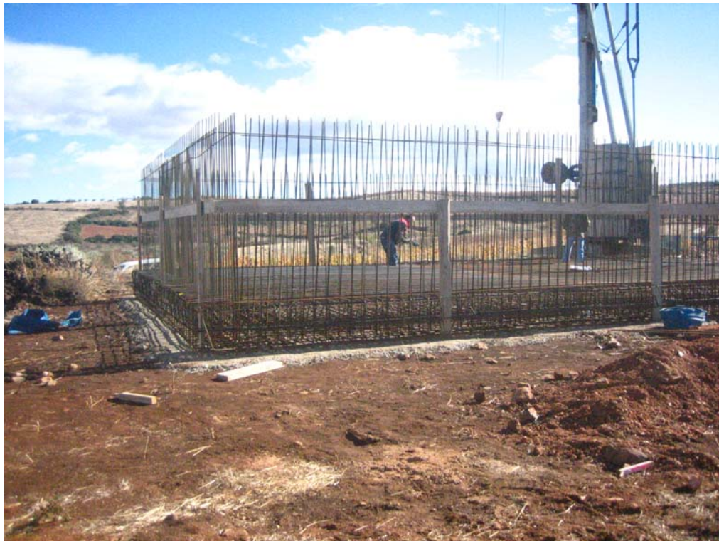
Presentación de la armadura completa de solera y las esperas de los muros.
