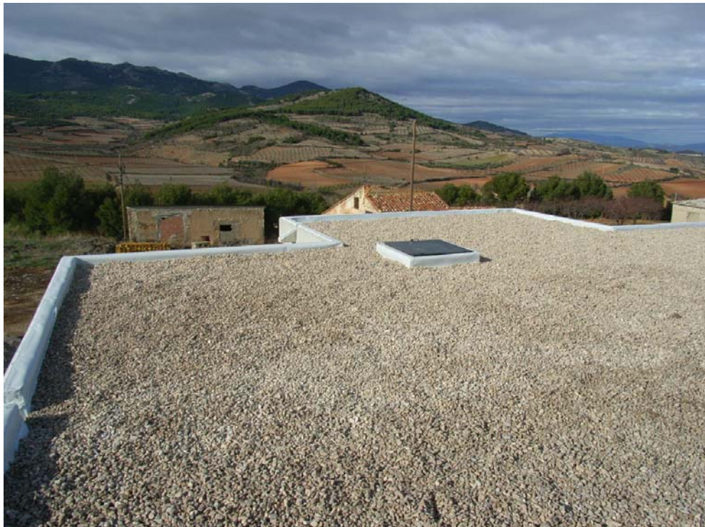
Cubierta invertida terminada.
