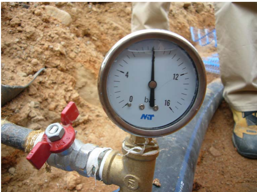
Prueba de carga a 8 Kg/cm 2 .
