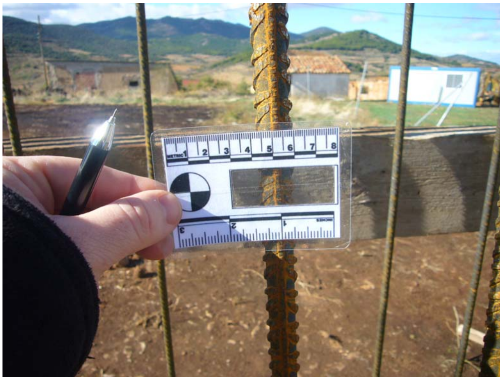
Empleo de testigo métrico para toma de fotos de comprobación de armadura.
