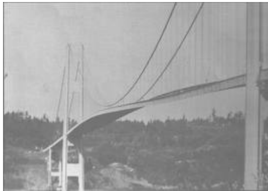
Figura 4.2.3.1.5 Modo de Torsión de la calzada
