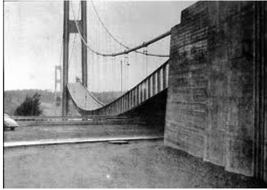
Figura 4.2.3.1.4 Modo longitudinal, Flexión de la calzada
