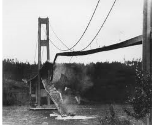
Figura 4.2.3.1.6 Fallo del puente
