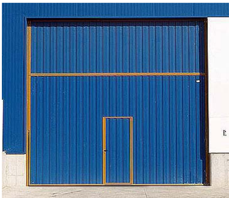
FIGURA 9. Puerta metálica autobasculante con puerta de acceso peatonal.
