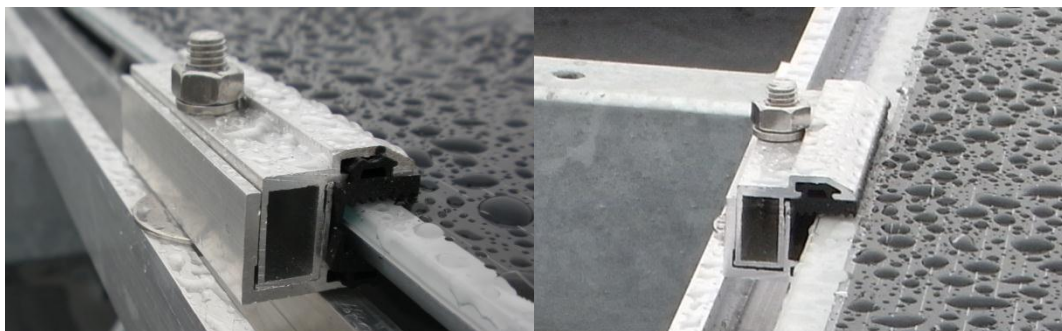
Figura 8: Pinzas de sujeción para extremos de la estructura
