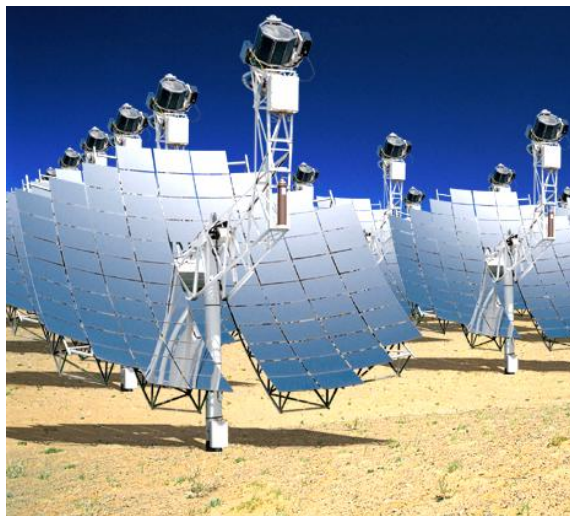
Fig. 5: Concentrador de facetas de vidrios
