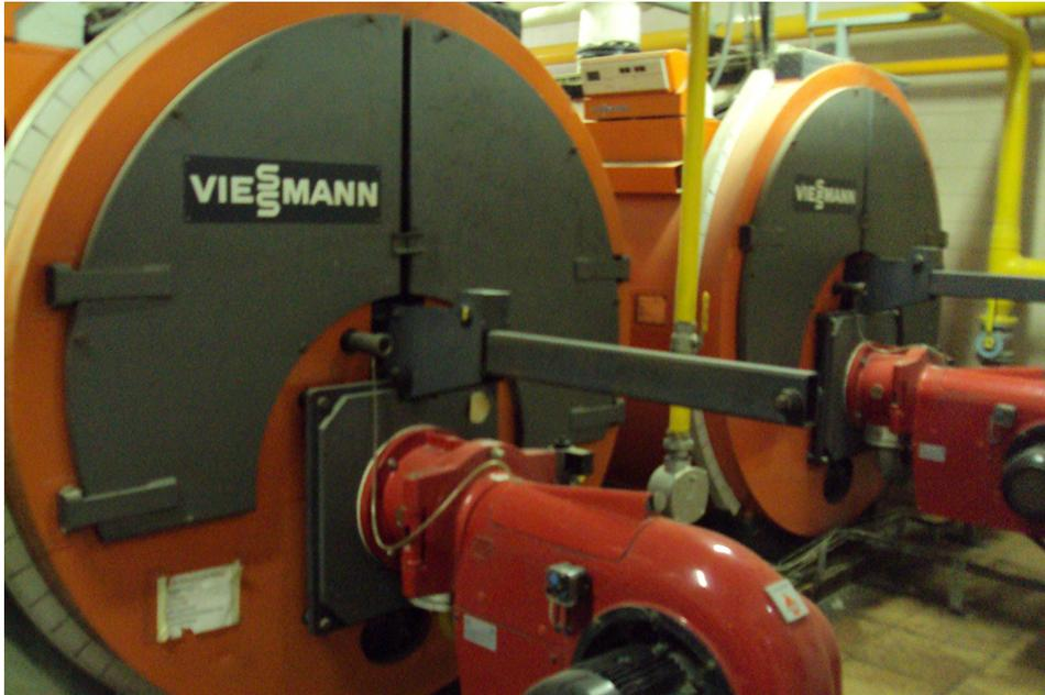
Imagen 45.- Calderas y quemadores de la sala de calefacción del edificio Torres Quevedo
