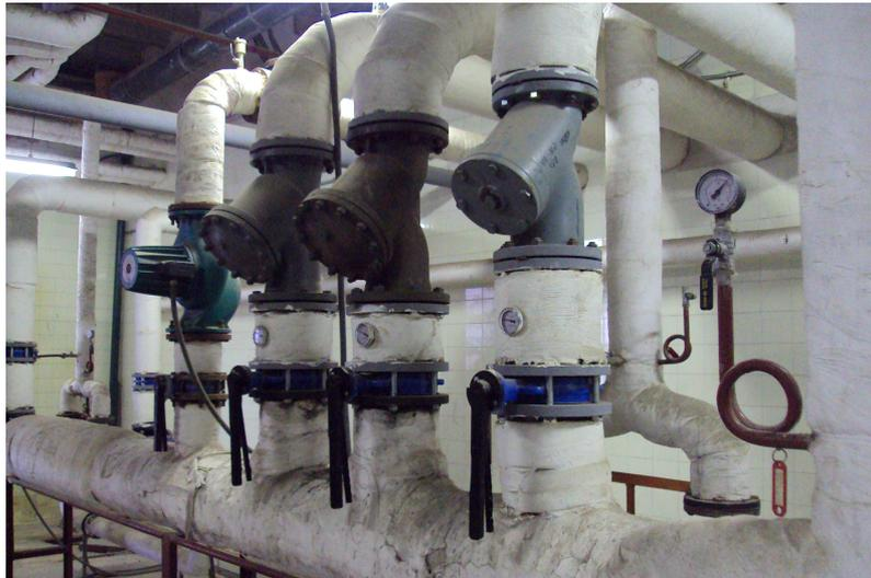
Imagen 47.- Válvulas y tubos de retorno de la sala de calderas
