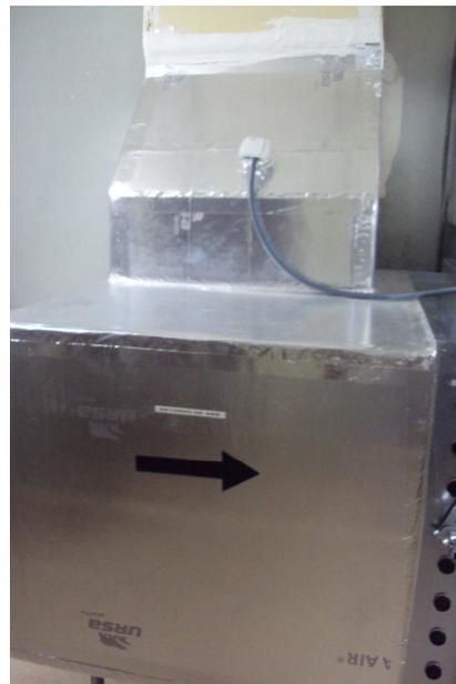
Imagen 49.- Sonda de Temperatura del retorno
