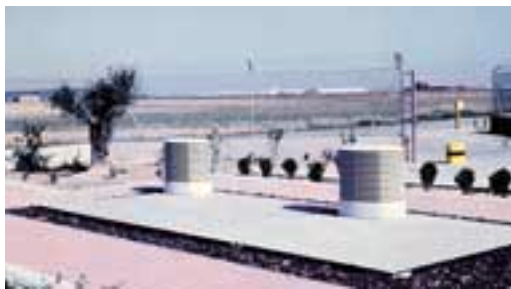
Acabado de un PFS-V de 1 transformador
