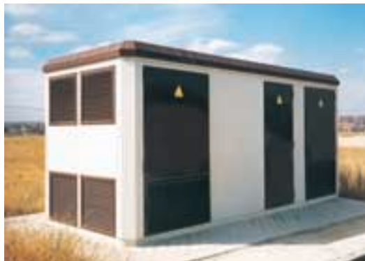
PFU-5 con 2 transformadores de 1000 kVA
