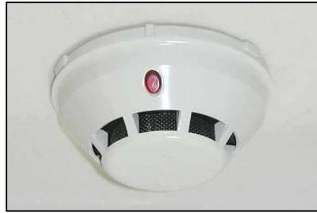
**Fig.99. Detector iónico.**
