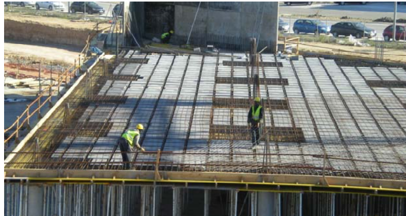
(2) Trabajadores montando forjado de edificio
