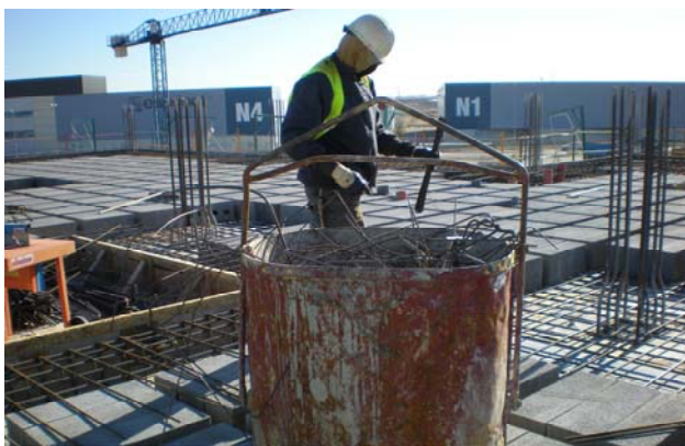
Uso de contenedores para recoger escombros
