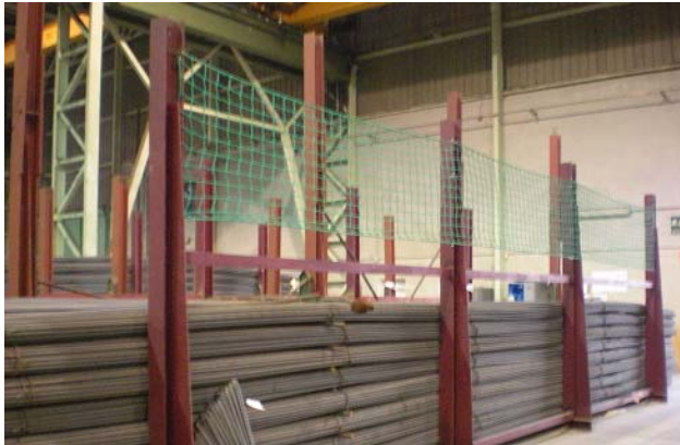
Redes en acopio para evitar caídas en altura
