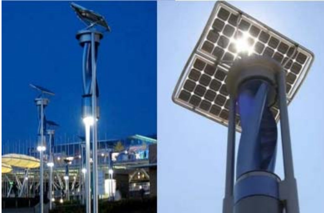
Fig 7.8 Sistema de iluminación híbrido instalado en Canadá
