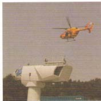
Fig. 6. 10 Aerogeneradores con acceso por helicópteros y helipuerto
