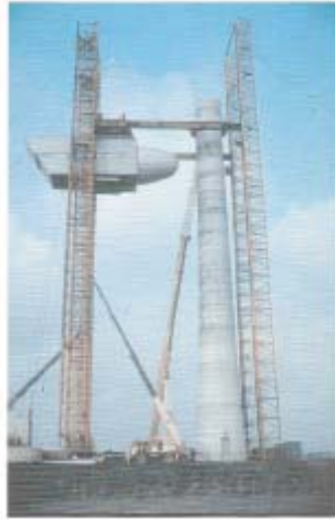
Fig. 3. 29 Aerogenerador con torre de hormigón
