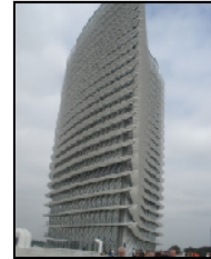
Foto Torre del Agua: Azucena Lostao. Julio 2008
