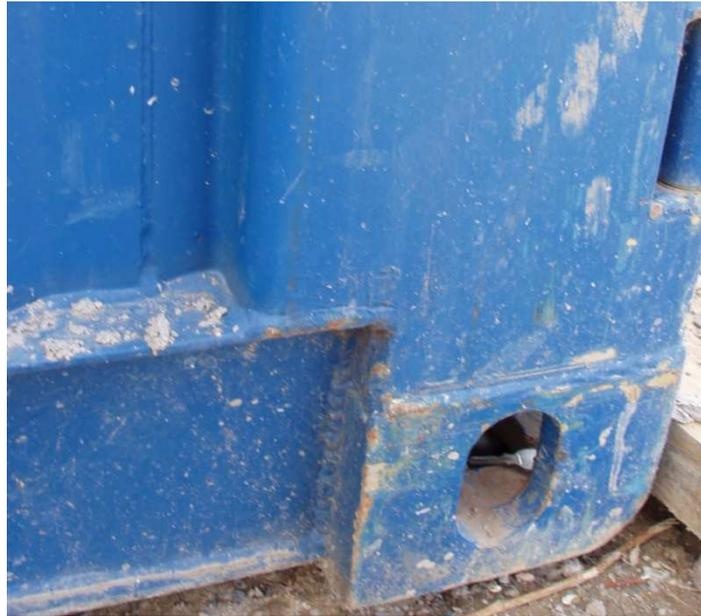
Figura 3.4. Refuerzo de las esquinas de un contenedor real.
