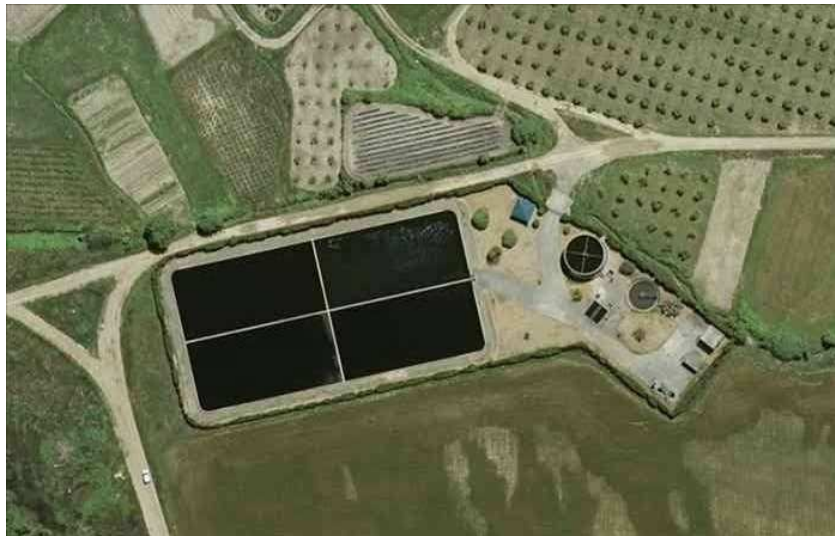
Figura 2.1: Planta depuradora objeto de estudio (Fuente: Google Earth, 2010)
