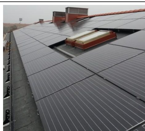
Figur 85 Landskapsorienterade solcellsmoduler. Eget foto från Vasakronans solcellsanläggning på Priorn, Malmö.
