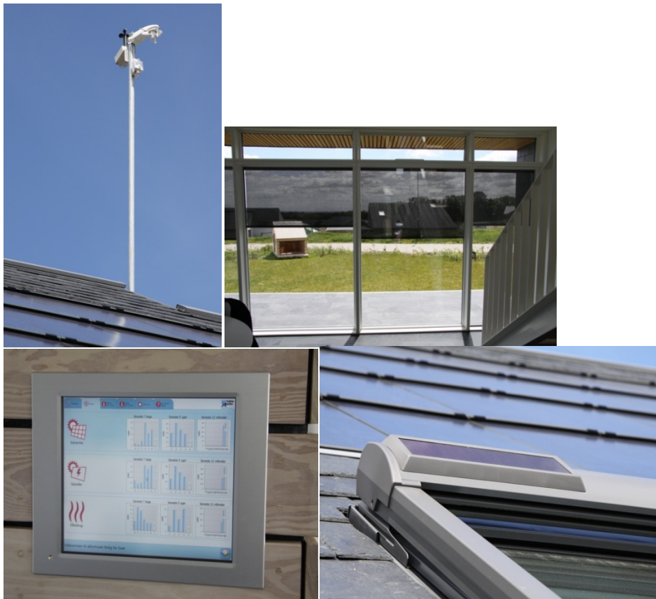
Bild 7 - Bolig for livet, aktivt styrsystem med vindsensor (längst upp tv), aktiv solavskärmning (uppe t.h.), Windowmaster (nere t.v.) och aktiva fönster för ventilation (nere t.h.)
