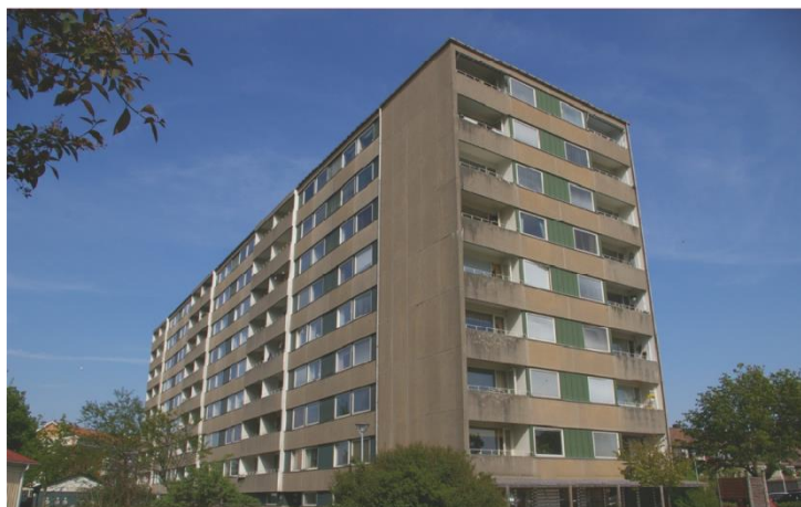
Figur 4. 1. Fastigheten Giganten 6 innan renovering 2012. (Lindell & Eriksson, 2013)
