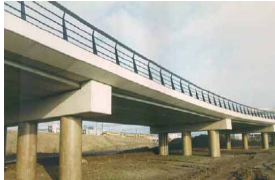
Figur 18 T.v. Krökt lädbalk, Holland. T.h. Utsmyckad kantbalk, Holland. (Strängbetong, 2009)
