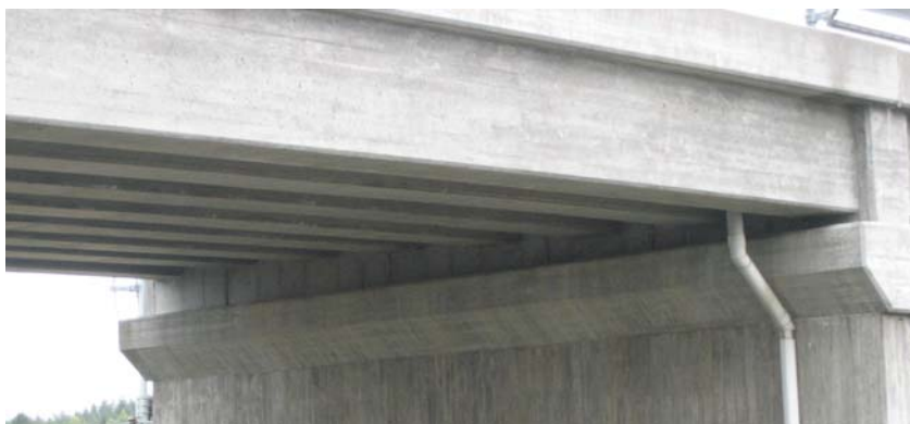
Figur 37 Närbild på komplicerad formning mellan balkar (fotograf, Hampus Jakobson)
