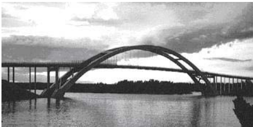
Figur 13 Bågbro (Vägverket (c), 2009)
