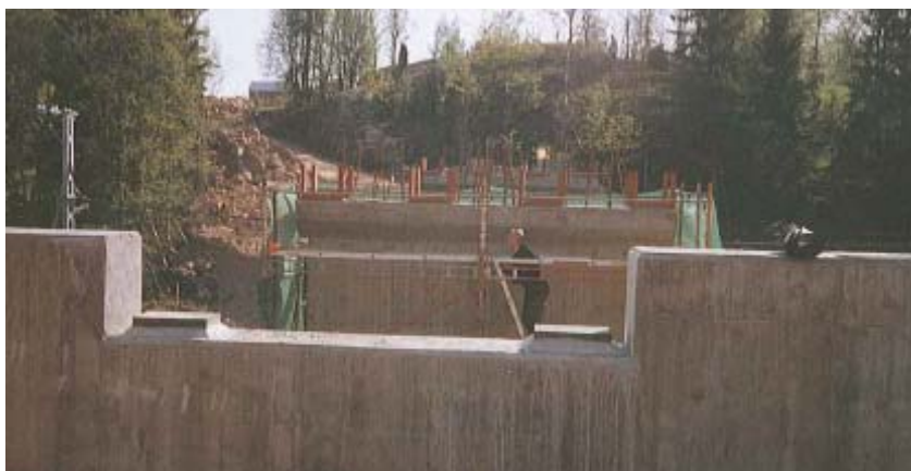
Figur 36 Temporära upplag på stöd inför montering (fotograf, Lars Lindeberg)
