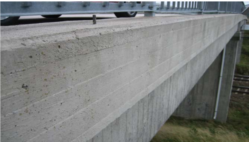
Figur 35 Närbild på kantbalk med tydligt brädmönster tillverkad på plats (fotograf, Hampus Jakobson)
