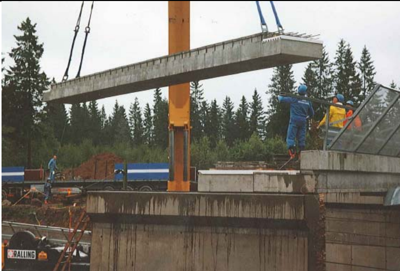
Figur 12 Montage av prefabricerad betongbro med förspända håldäckplattor (fotograf, Lars Lindeberg)
