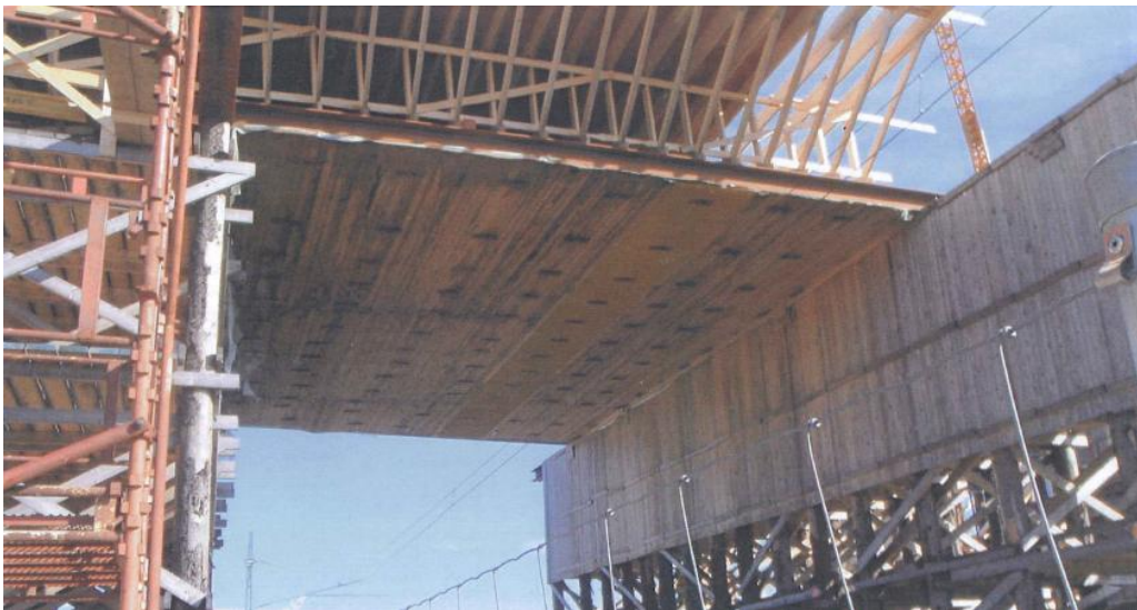
Figur 32 Exempel på brädform (fotograf, Jan Sandberg)
