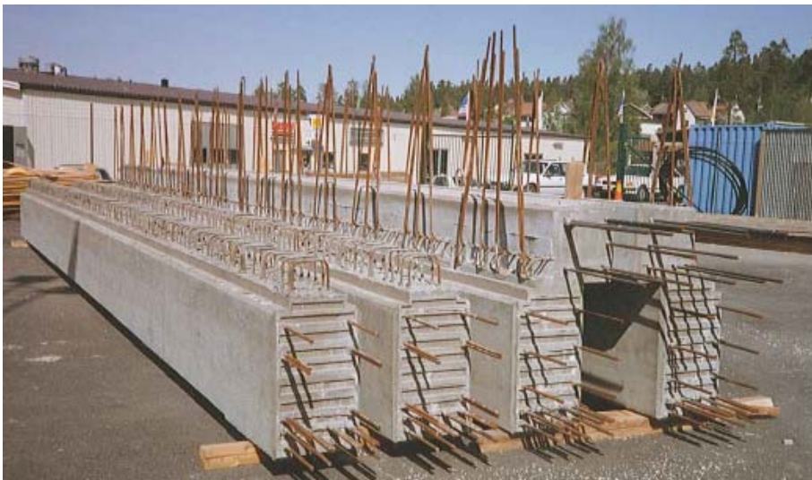
Figur 10 Prefabricerade betongbalkar till NCC Bron (fotograf, Lars Lindeberg)
