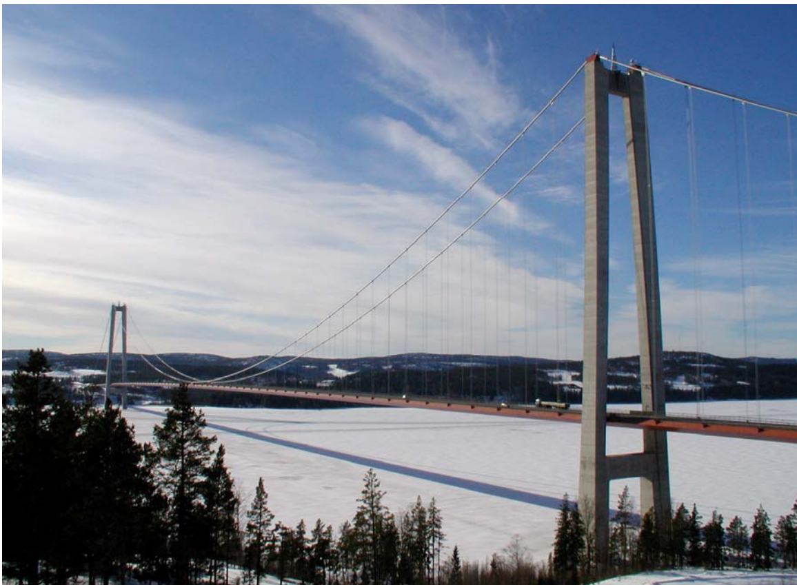
Figur 15 Høga kysten bron, spännvidd 1210 meter (Härnösands kommun, 2009)
