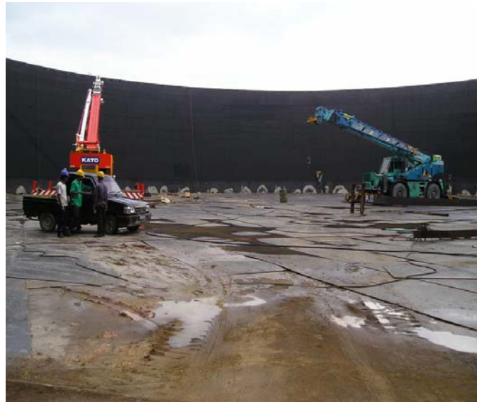
Gambar 5. Kegiatan pembersihan dengan teknik “sand blasting”
