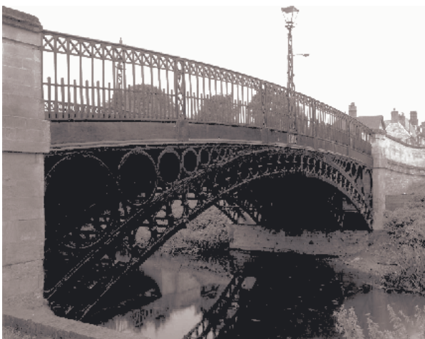
Tickford Bridge, Newport Pagnell
