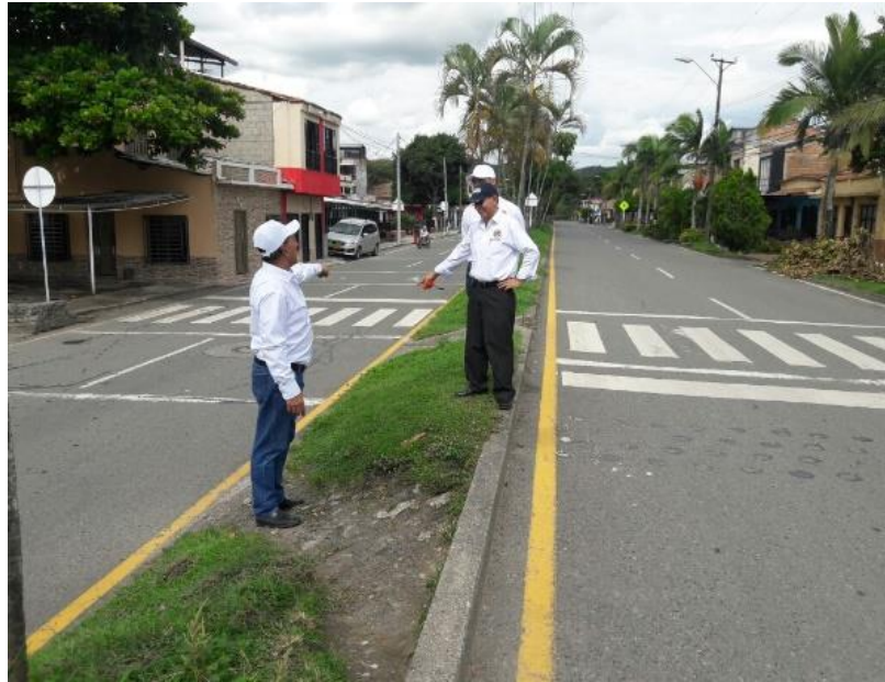
Figura 11 Paso peatonal demarcado interrumpido por sardinel.
