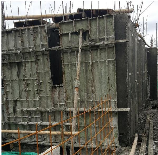
*Figura 1. Muros vaciados*
