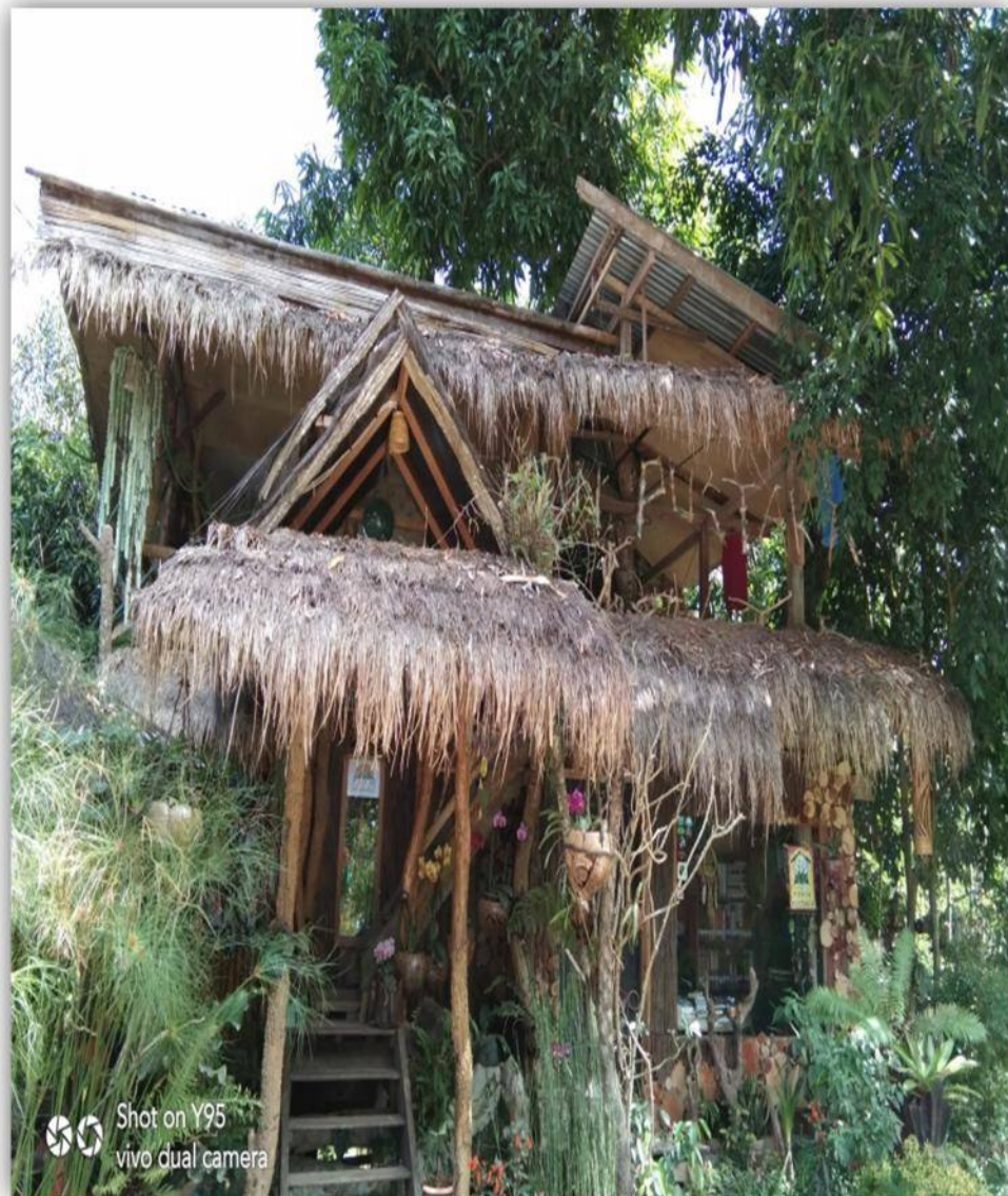
Gambar 2 : Bagunan Pohon Pustaka
