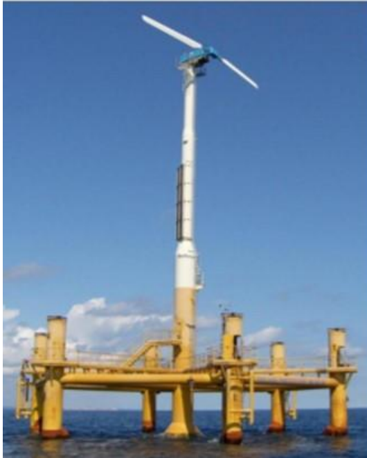
Figura A 18. Plataforma para instalación del Aerogenerador. Tomado de:(Guzmán Montón, Ulzurrun Romero, & Herreros Sierra , 2018)
