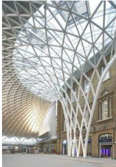
Gambar 13.. Sistem Struktur Space Frame (Sumber: Internet, 2019)
