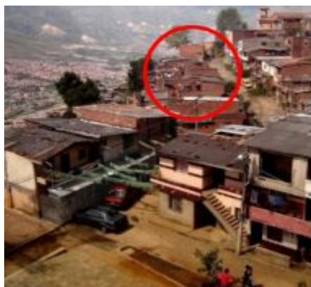
Antes de la intervención (2004)
