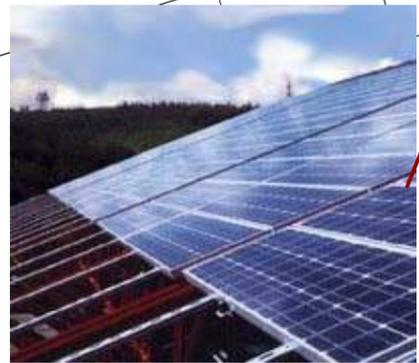
UTILIZACION DE CELDAS FOTOVOLTAICAS POLICRISTALINAS.
