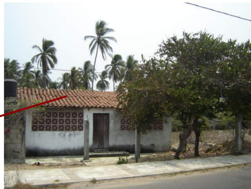
EL SISTEMA CONSTRUCTIVO MAS EMPLEADO EN EL SITIO ES A PARTIR DE COLUMNAS Y TRABES DE CONCRETO ARMADO POSIBLEMENTE LEVANTADAS SOBRE ZAPATAS TAMBIEN DE CONCRETO ARMADO O DE PIEDRA BRAZA.
