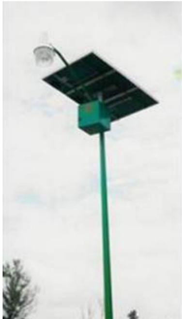
PARA LA GENERACION DE ELECTRICIDAD SE PRETENDE REALIZAR POR MEDIO DE MODULOS FOTOVOLTAICOS, A PESAR DE QUE NO SE CUENTA CON UNA GRAN RADIACION ESTE SISTEMA FUNCIONA CON LUZ DIFUSA.
