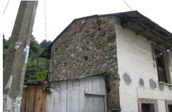
Techumbres a doble agua de lámina de zinc.
