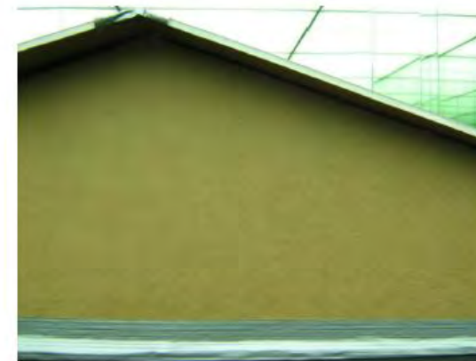
FOTO 3 FACHADA OESTE SIN DISPOSITIVOS
