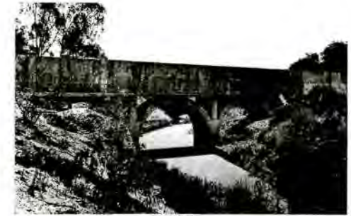
Puente de Tecamachalco. Obras para la provisión de agua potable, 1951
