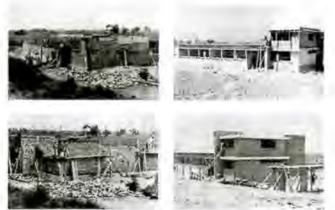
Escuela primaria en el pueblo de San José del Llani-to. Obras para la provisión de agua potable. 1951.
