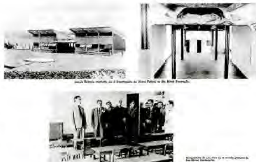
Escuela primaria en Santa María Atarasquillo. Obras para la provisión de agua potable. 1951.
