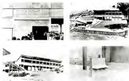
Centro Escolar en Santa María Atarasquillo. Obras para la provisión de agua potable. 1951.
