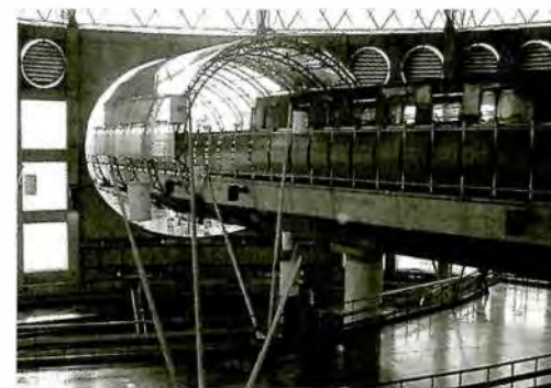
Estación del metro San Lázaro interior.
