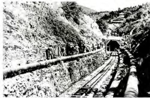
Portal de entrada al túnel de Atarasquillo-Dos Ríos. Obras para la provisión de agua potable, 1951
