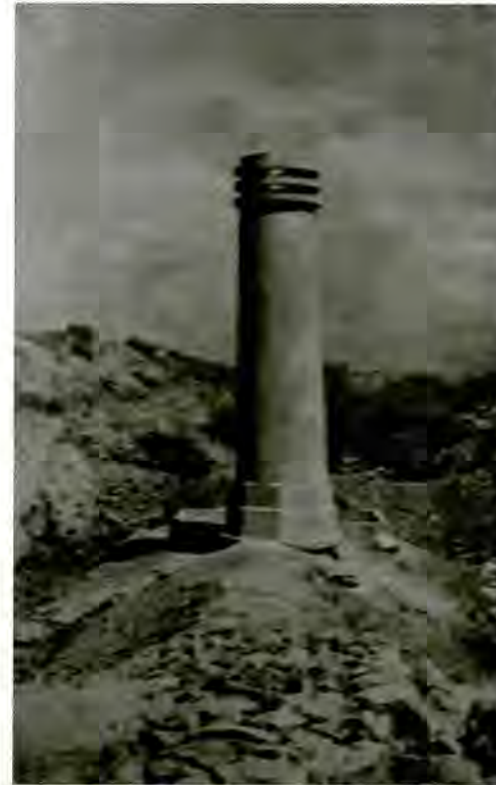
Chimeneas de ventilación. Se construyeron cada kilómetro a lo largo del acueducto. (Fuente: Molina, 1949:13).
