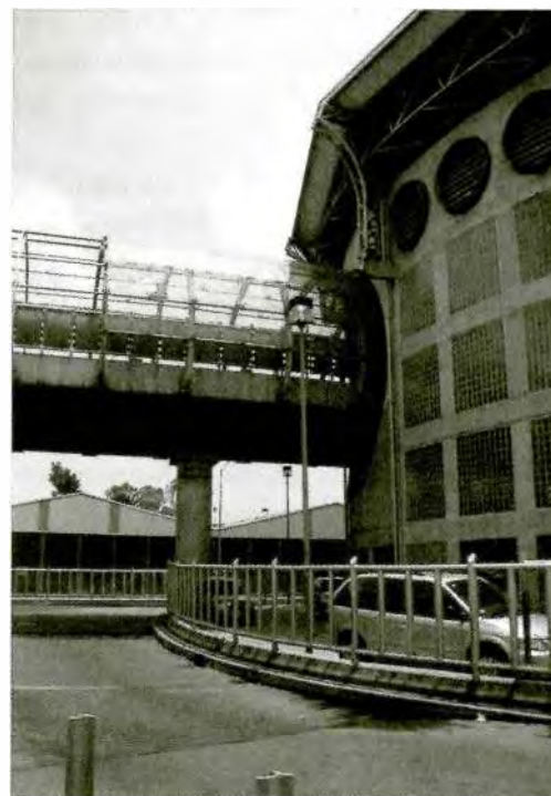
Estación del metro San Lázaro, exterior.
