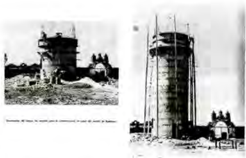
Tanque de almacenamiento para el abastecimiento del pueblo de Almoloya. Obras para la provisión de agua potable. 1951.
