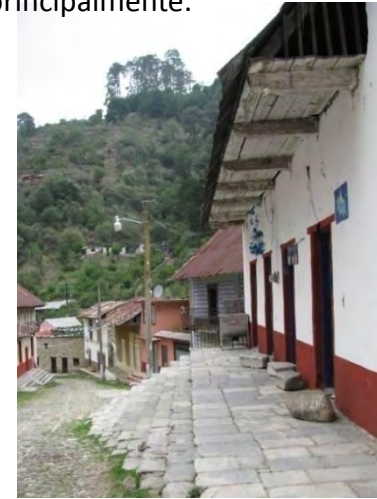
Uso de tapanco como aislante térmico en área de alojamiento.
