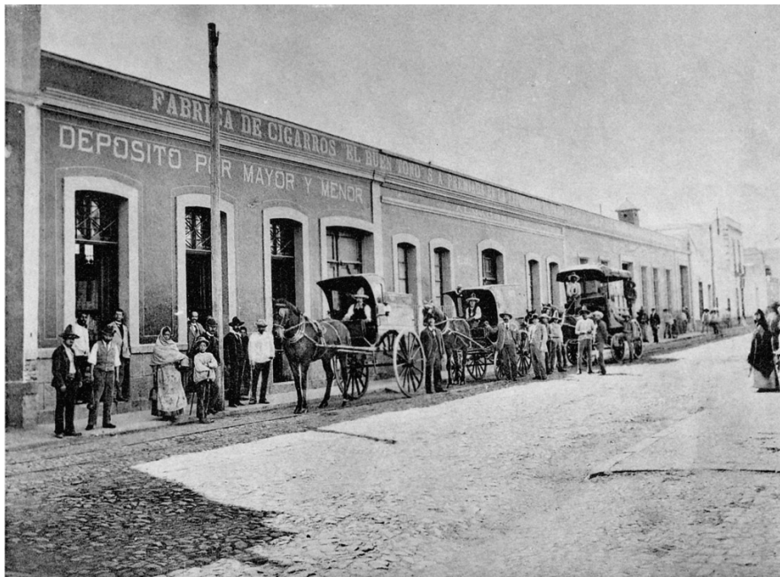
Fachada original de la fábrica sobre el callejón de San Antonio. Álbum El Buen Tono, S.A. Capital social $1,000,000. Dir. Gerte. E. Pugibet, México, donación de Julio Romo Michaud a Raíces Francesas en México, A.C.
