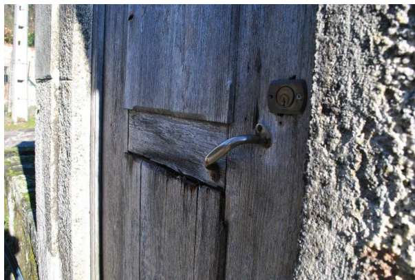
Figura 101. Pormenor de porta de acesso ao volume
