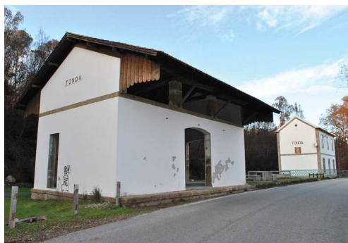
Figura 64. Vista exterior do equipamento de armazém, com todas as caixilharias em madeira retiradas e vão das “traseiras” aberto
