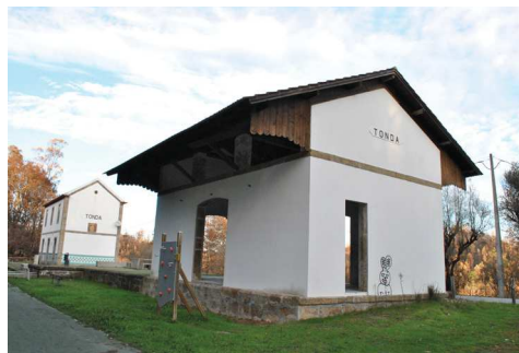
Figura 55. Vista exterior do antigo armazem em desuso
