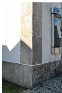
Figura 13. Pormenor de tratamento e adaptação de rede elétrica e telefónica para novo layout
