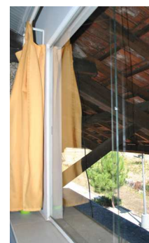
Figura 35. Pormenor de novas caixilhariias em alumínio colocadas após reabilitação
