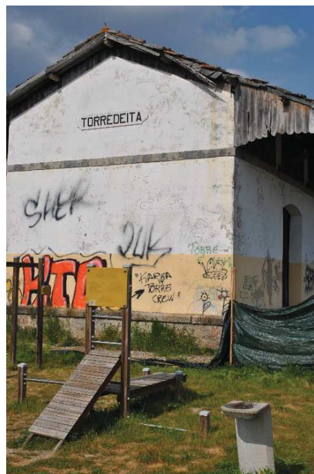
Figura 96. Estado das madeiras da cobertura visível pelo exterior
