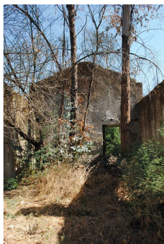
Figura 76. Vista pelo lado interior do antigo armazém, com vegetação ao longo de todo o pavimento
