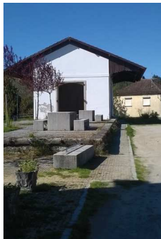
Figura 46. Vista exterior de antigo armazém
