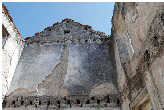
Figura 74. Pormenor interior com negativos da estrutura em madeira nas paredes de pedra, indiciantes da forma como se orientava a estrutura de apoio à laje e cobertura
