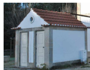
Figura 50. Vista exterior de pequeno equipamento de apoio com instalações sanitárias, com substituição de portas por madeira lacada branco
