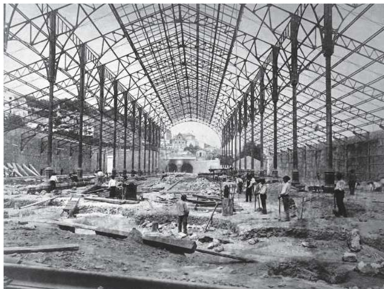
Figura 3. Estação do Rossio em construção
