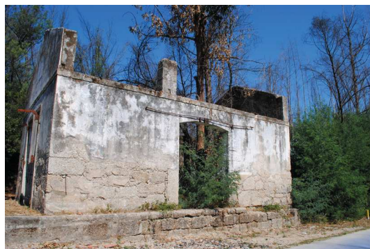
Figura 75. Vista atual de antigo volume de armazém da Estação de Treixedo
