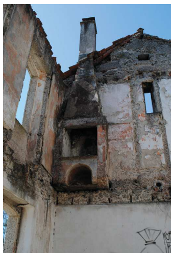
Figura 72. Pormenor interior de chaminé em pedra, para uso na antiga habitação do chefe de estação
