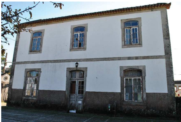
Figura 102. Vista geral dos vãos da fachada Norte
