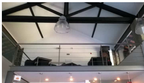
Figura 17. Piso superior em mezanino com estrutura metálica e estrutura da cobertura em madeira preservada, à vista
