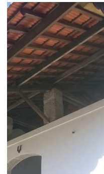
Figura 48. Estrutura de madeira e esteio de pedra para suporte de cobertura
