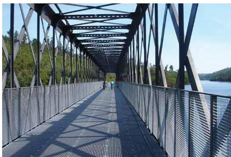
Figura 7. A Ponte Mosteirinho após adaptação para passagem pedonal da Ecopista
