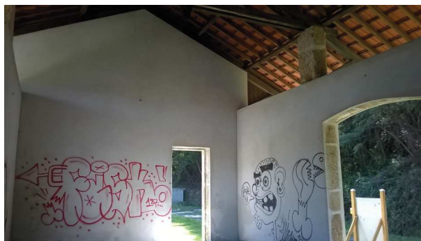
Figura 65. Vista pelo interior do equipamento de armazém, com vestígios de reabilitação a nível de pinturas (vandalizadas posteriormente) e estrutura em madeira à vista
