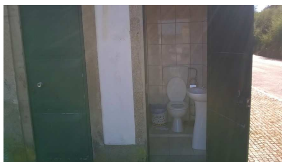
Figura 57. Instalações sanitárias de apoio, com portas em chapa de alumínio verde
