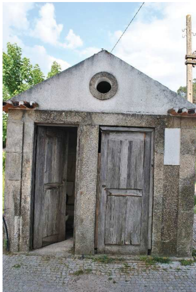
Figura 99. Estado dos vãos exteriores do edifício das instalações sanitárias
