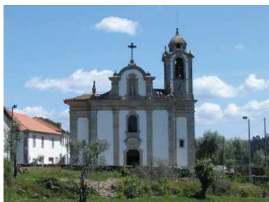
Figura 78. Igreja Matriz Torredeita
