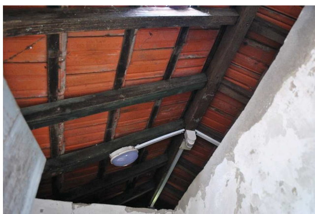
Figura 91. Cobertura de volume de casa de banho pelo interior
