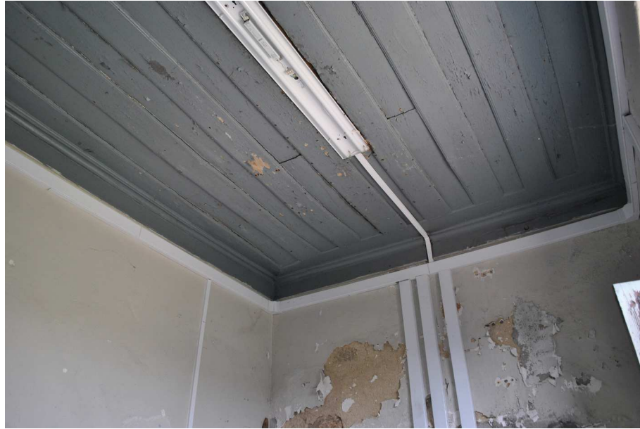
Figura 85. Pormenor de parede exterior pelo lado interior
