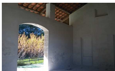
Figura 49. Interior de antigo armazém com pormenor de fecho de portas/janelas pré-existent
