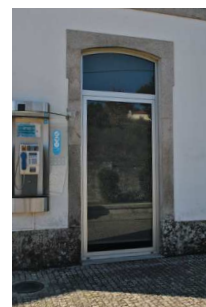
Figura 14. Pormenor de vão exterior com caixilharia em alumínio, substituindo a antiga porta em madeira da fachada Este
