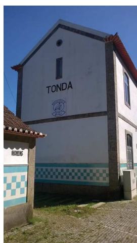
Figura 62. Vista exterior do equipamento central, com reboco areado substituído por peças cerâmicas
