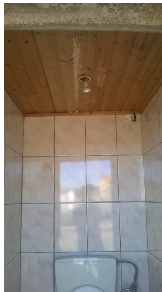
Figura 59. Interior de instalações sanitárias, com teto falso em forro de madeira
