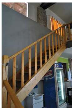
Figura 30. Escada em madeira de acesso a piso adicionada após reabilitação sentido ascendente
