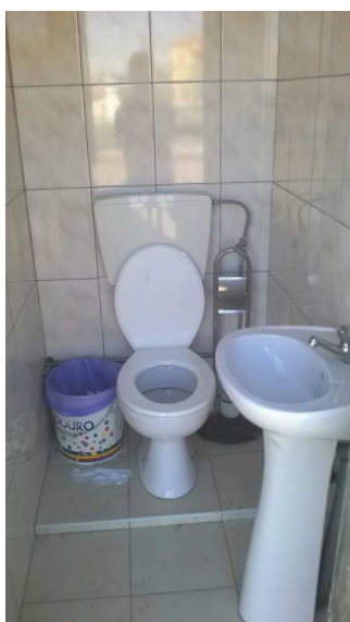
Figura 58. Interior de instalações sanitárias, com louças e cerâmicos novos
