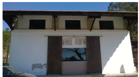
Figura 24. Alçado Oeste do antigo volume de armazém, atualmente usado como restaurante
