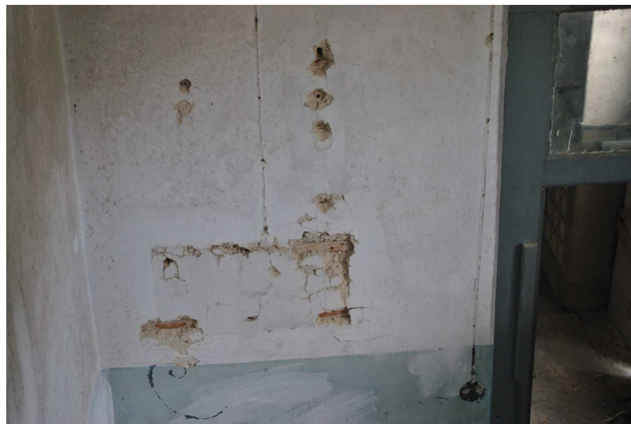
Figura 86. Parede interior com estrutura de tabique exposto
