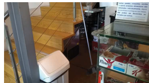
Figura 18. Pormenor de escada de acesso a piso superior revestida em madeira
