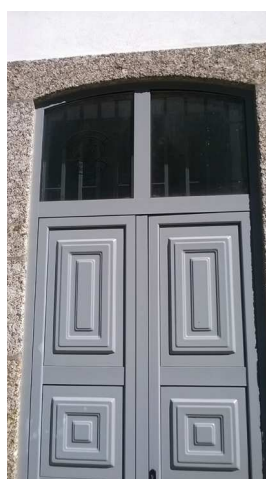
Figura 63. Pormenor dos vãos exteriores em madeira lacada com vidro temperado no topo
