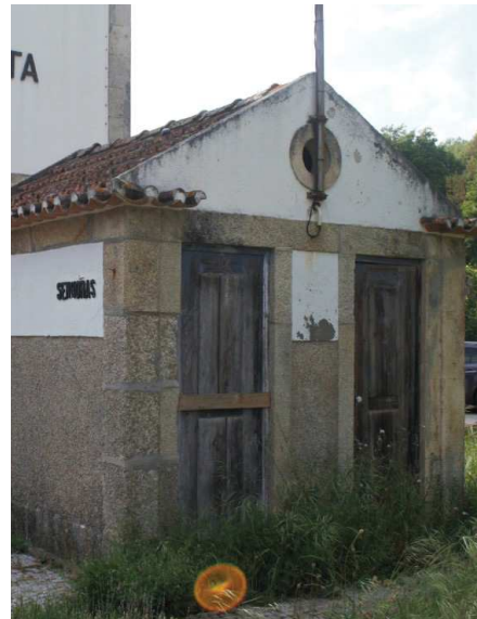
Figura 100. Fachada Este do volume sanitário
