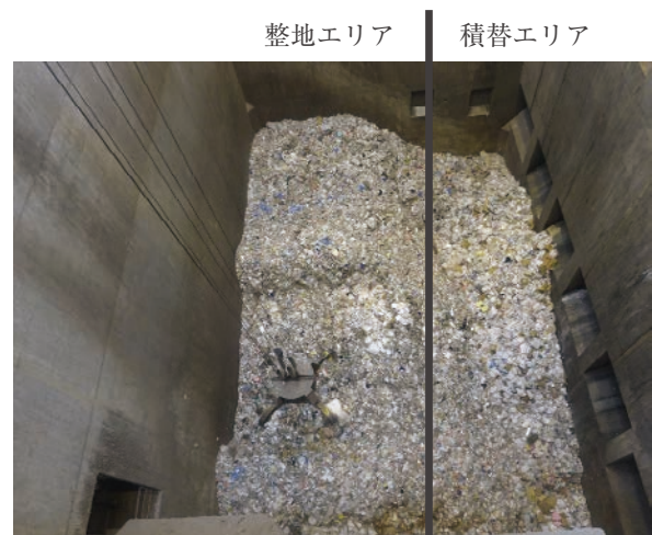
図2 ごみピット内
