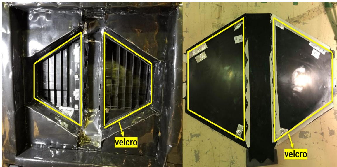
Figure 5-13 Velcro placé sur le châssis et sur la plaque protectrice
