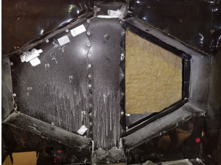
Figure 5-10 2'' de laine de roche mise en place dans les cavités droite et gauche du plancher
