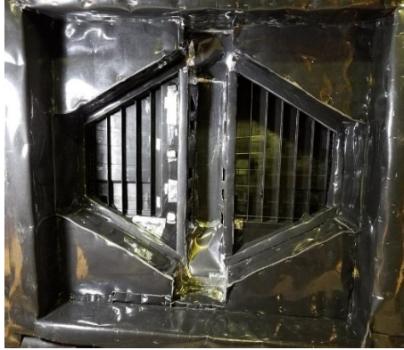
Figure 4-6 Montage du système simple paroi (coté anéchoïque)
