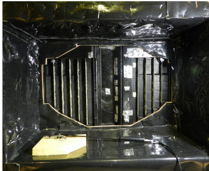
Figure 3-43 Mastic sur les raidisseurs du plancher
