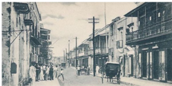
Imágenes de Santo Domingo en 1920, que da testimonio del desarrollo urbanístico y comercial de la época, así como la moda y medios de transporte. Se destaca la electrificación y los buzones de correos en las avenidas principales. Fuente: Google.com (2019).
