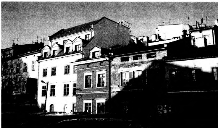
Fot. 1. Kazimierz, nadbudowa kamienicy przy ul. Szerokiej
