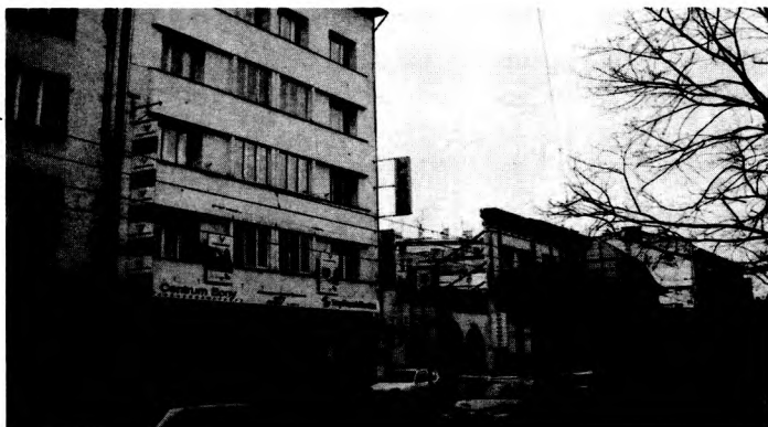
Fot. 3. Ściana frontowa kamienicy pozostała po wyburzeniu całej reszty przy ulicy Karmelickiej 66
