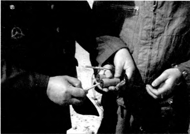
Obr. č. 6. Zostavovanie náložiek 2 x 75 g TNT
