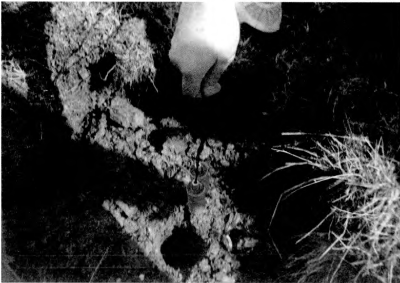
Obr. 2. 7. Umiestňovanie náložiek do vývrtu
