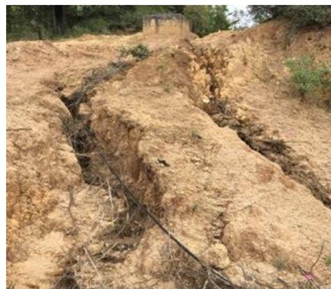
6. Los cortes efectuados a las laderas naturales generan inestabilidad en el terreno, el cual, por ser arcilloso, suele saturarse de agua y perder estabilidad con mayor facilidad. En la zona de estudio existen diversos taludes, los principales fueron elaborados para la creación de caminos y senderos
