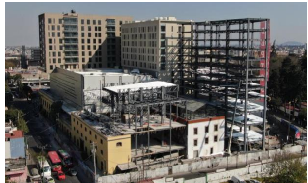
Figura 6. Paseo Molino vista actual. Fuente: Revista Centro Urbano.
