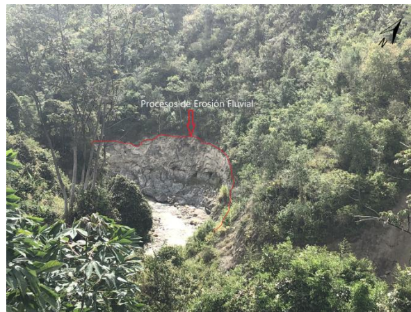
Figura 73. Procesos Erosivos Fluviales de la Cuenca del Río Neiva
