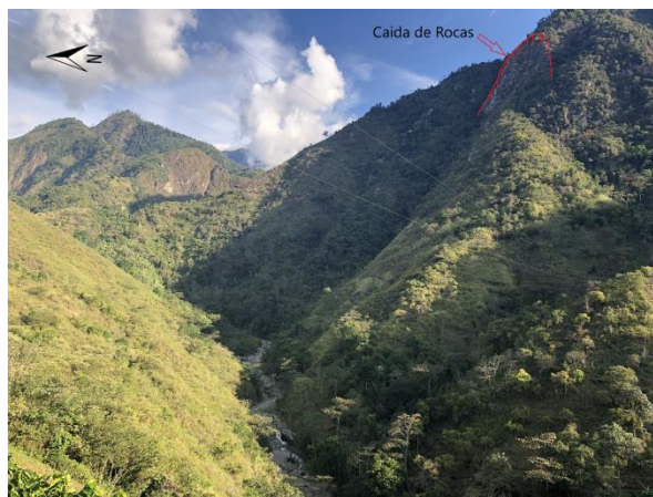
Figura 64. Caída de Rocas de la Cuenca del Río Frío Rivera
