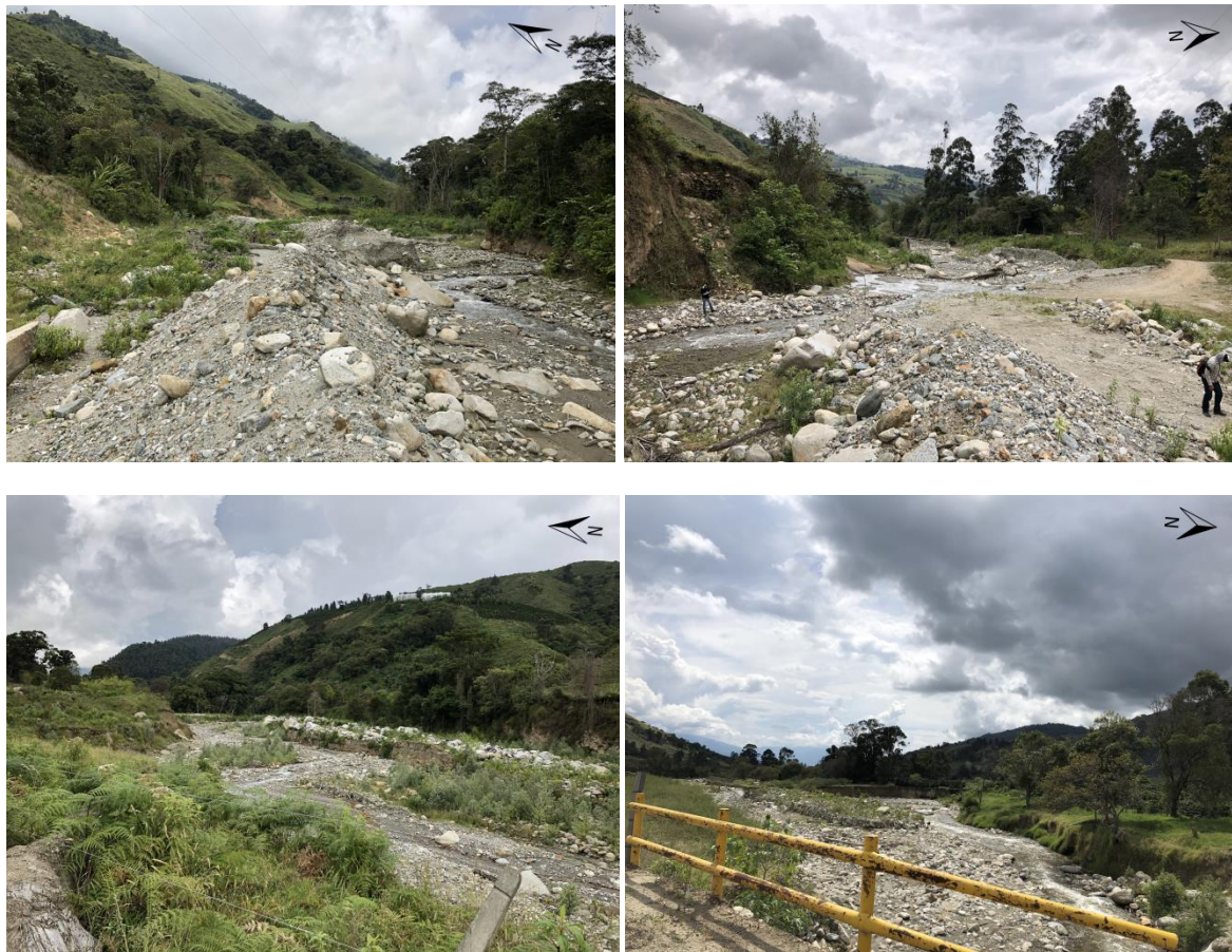
Figura 117. Sedimentos transportados y afectación generada por el evento en el río Neiva
