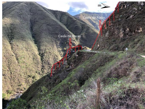
Figura 60. Caída de Rocas de la Cuenca del Río Ceibas
