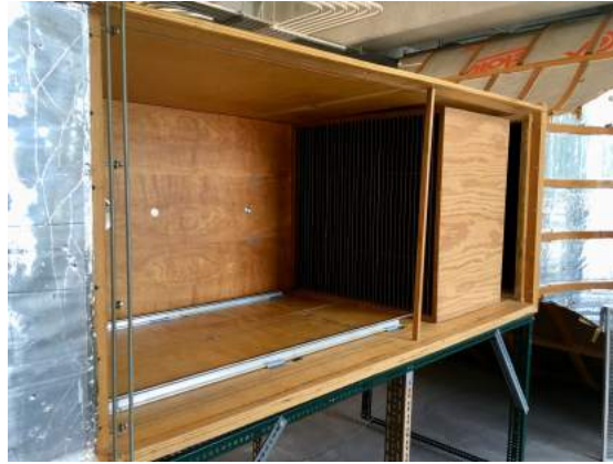
Figura 3.16: Instalación del enderezador de flujo en el túnel de viento.
