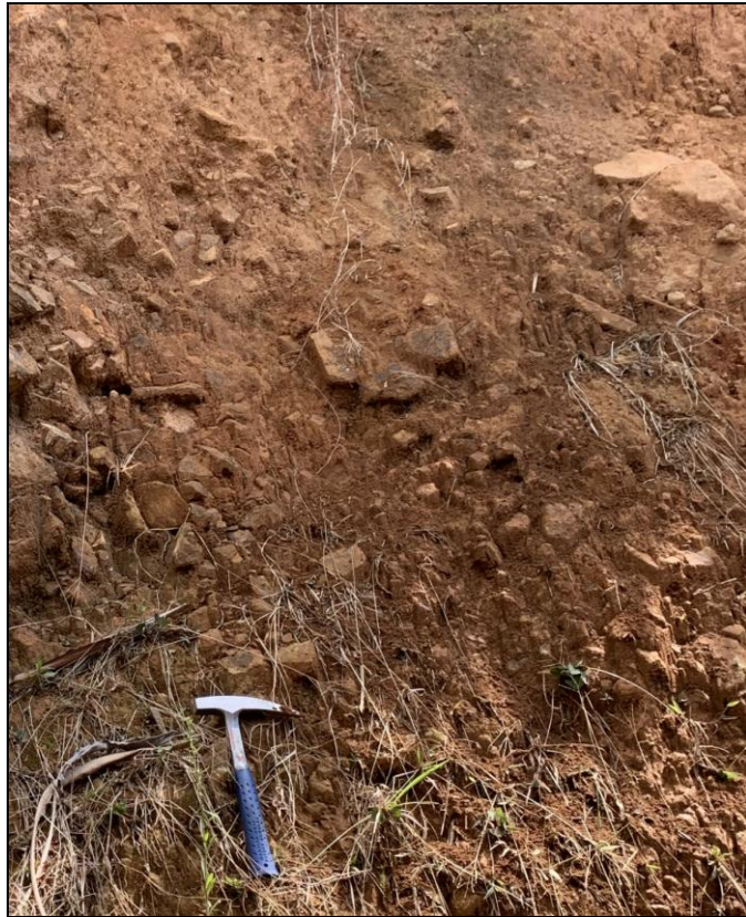
Figura 15. Flujos de escombros y lodos
