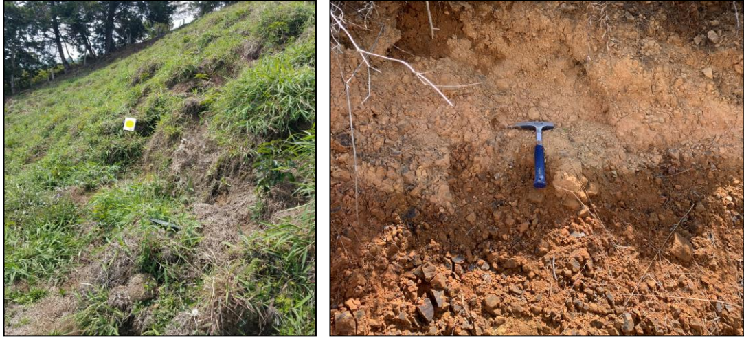
Figura 12. Flujo de lodos y escombros
