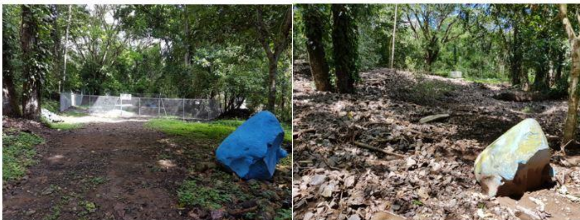
Figura 5.2. Antes y después de emergencia (octubre 2018). Fuente: (R., Arias comunicación personal, 10 de diciembre, 2018).
