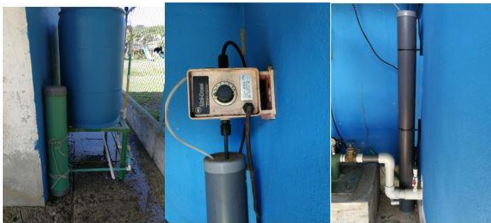
Figura 5.13. Sistema de cloración del pozo Laberinto
