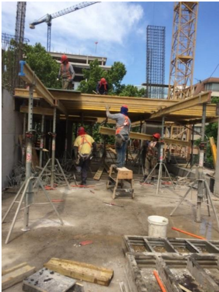
Fotografía D.2: Cuadrilla de moldaje de losa.
