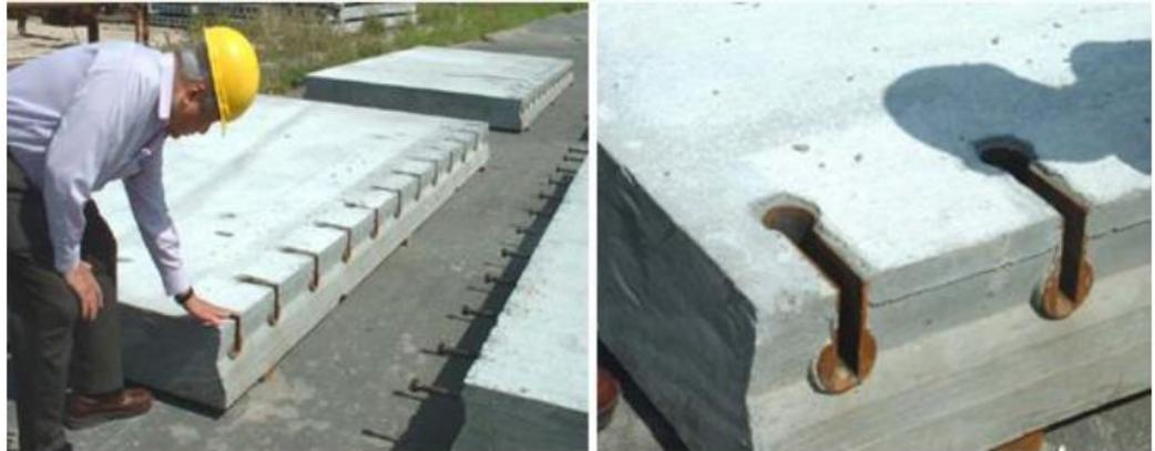
**Figura 2.4:** Detalles de la unión entre módulos prefabricados de módulos de hormigón con el método Kwik Slab. Fuente: (Honolulu, Hawaii. USA Patente nº 7,134,805 B2, 2006)
