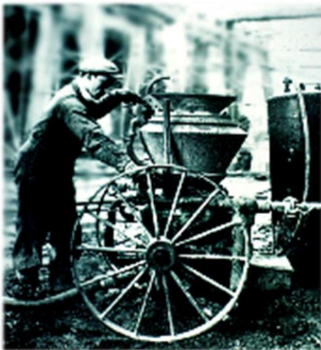
Imagen 2.3 Equipo de shotcrete utilizado en 1920 d.C.
