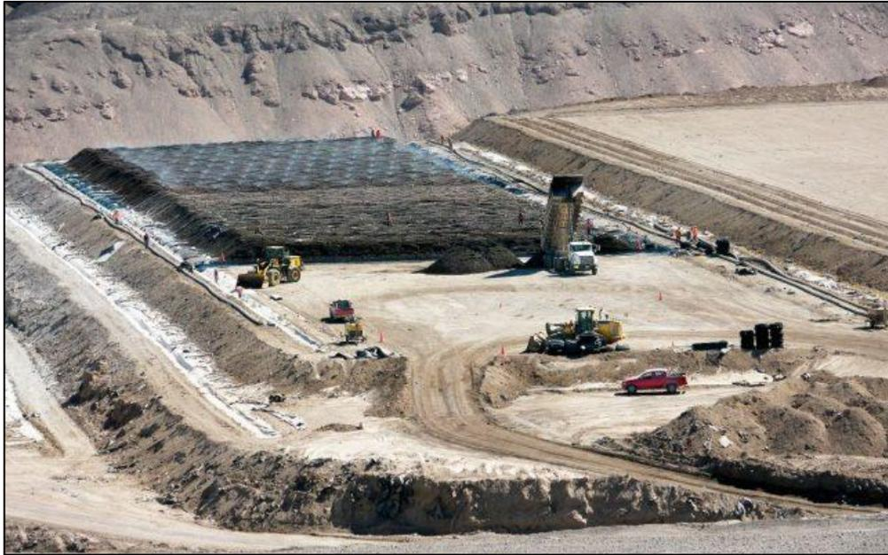
*Imagen 1: Preparación de una pila de lixiviación dinámica en la Minera La Cascada*
