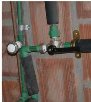
**Figura VI-10:** Válvula manual de tres vías
