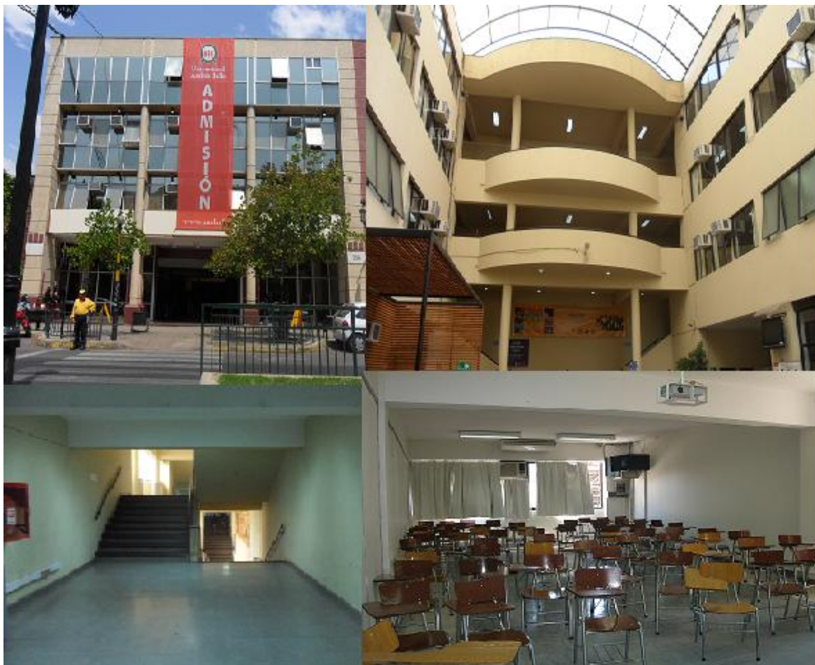
Figura 3.5.- Imágenes del edificio
