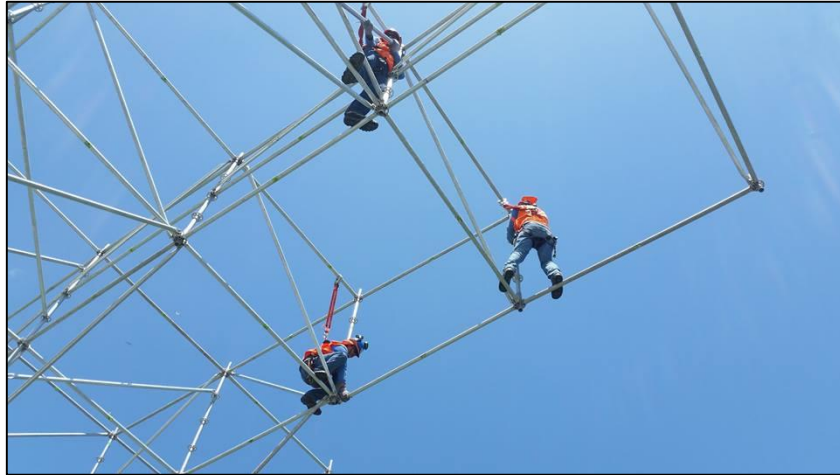
Figura II.2: Montaje de Andamios en voladizo para techo de escenario.
